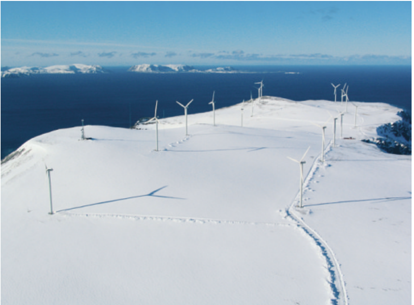
Figur 21: Havøygavlen vindkraftverk i Finnmark vinterstid. De 16 vindturbinene à 2,5 MW har 80 m tårnhøyde og 80 m rotordiamenter.
