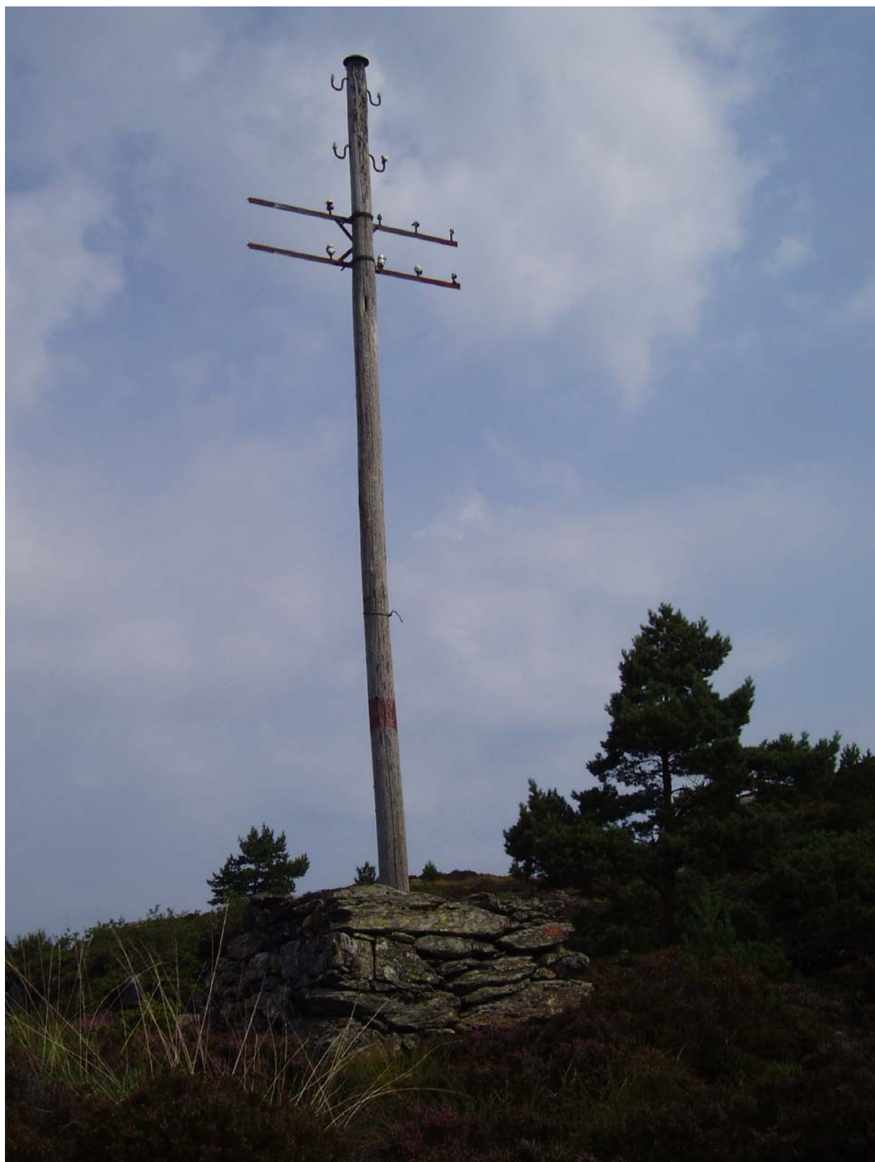
Figur 3.9 Gammel telefonstolpe ved Storamyrn øst for Sætrradalen
