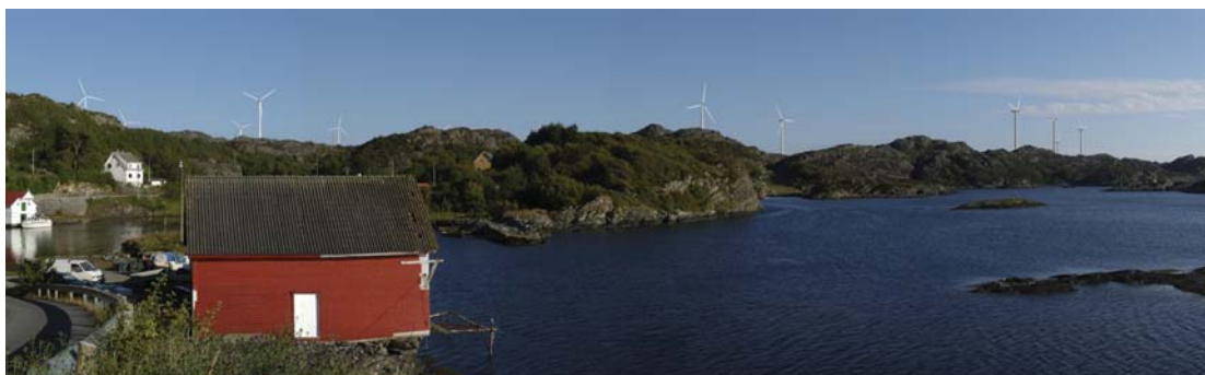
Figur 7.1 Langevåg vindpark (versjon B2) sett fra Skippervika
