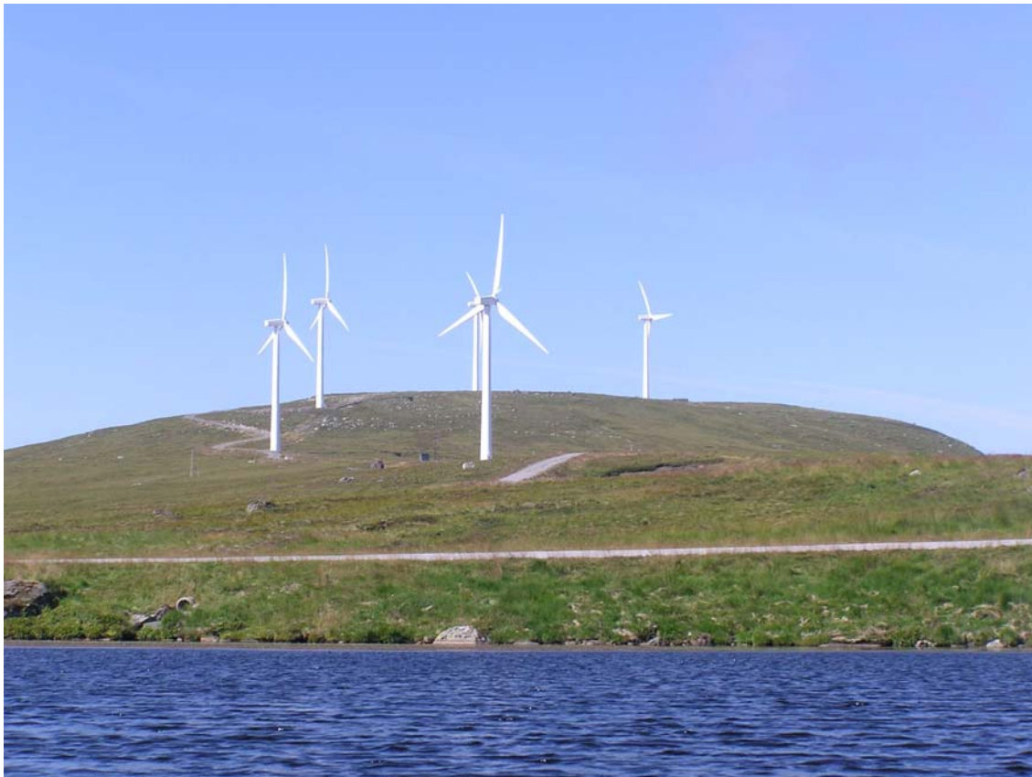
Figur 2 Eksisterende vindpark på Mehuken sett fra Movatn. Foto: Ragnar Myhre
