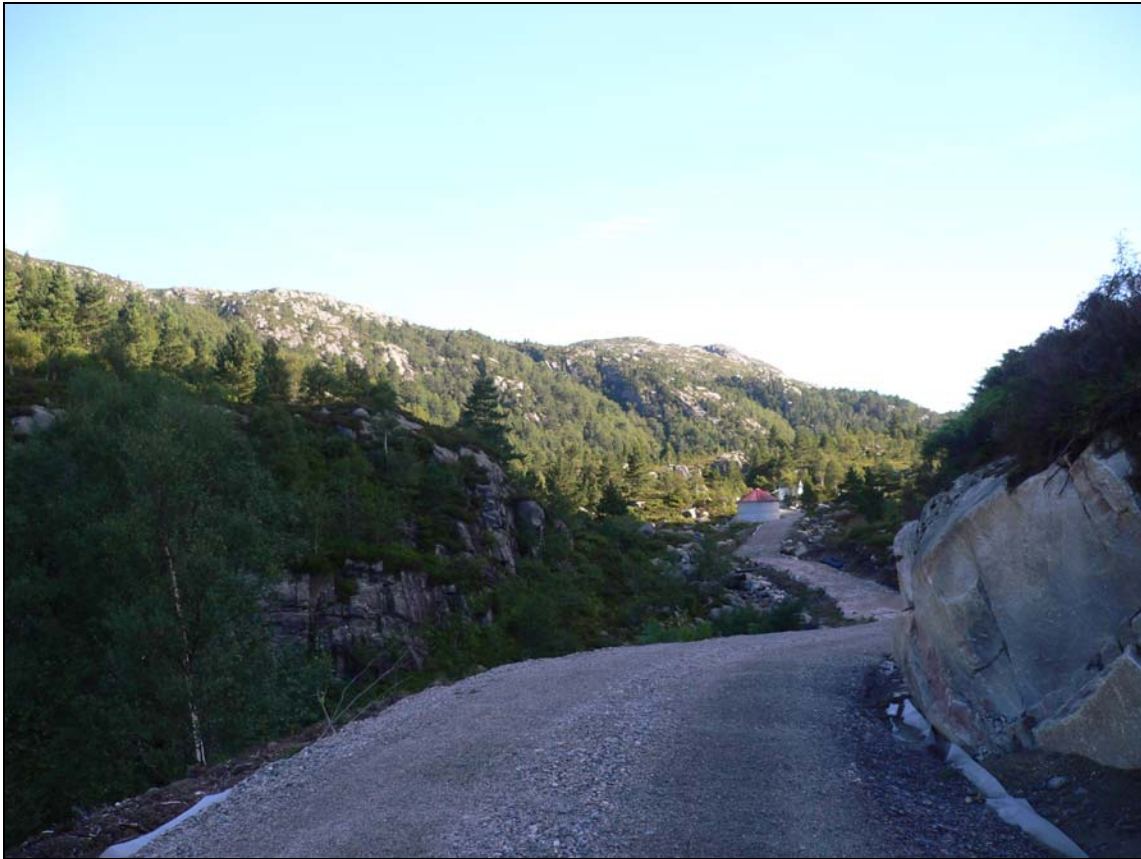
Figur 7.15: Adkomstveien følger eksisterende vei i starten. Foto: Gunnar Henriksen.
