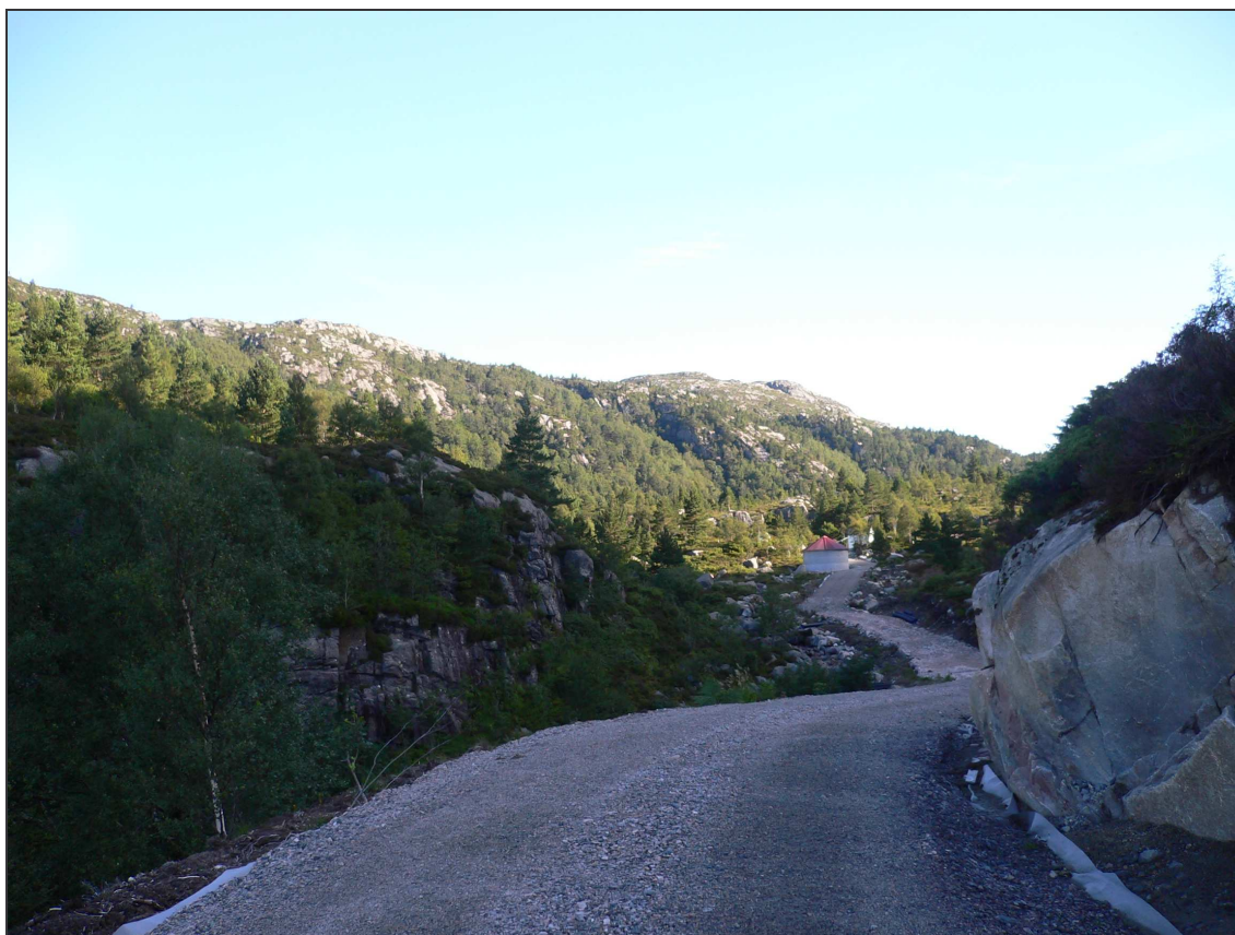
Figur 6.3. Adkomstveien følger eksisterende vei i starten). Foto: Gunnar Henriksen
