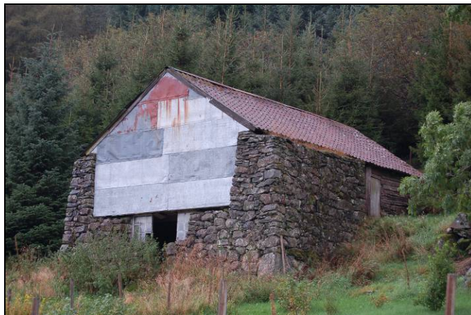
Utløe med steinkonstruksjon fra Li (Foto: I. Lindblom 2005).
