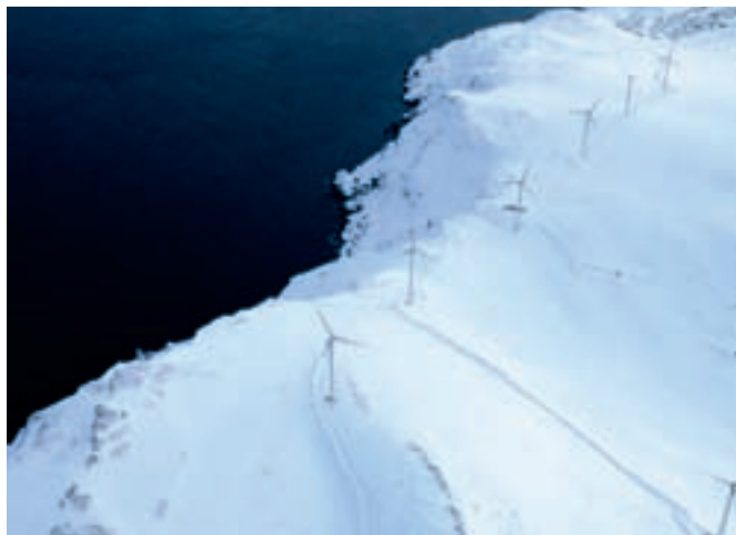
Fig. 9 Illustrasjon av hvordan Havøygavlen vindkraftverk i Finnmark tar seg ut vinterstid. De 16 vindturbinene har en samlet installert effekt på 40 MW
