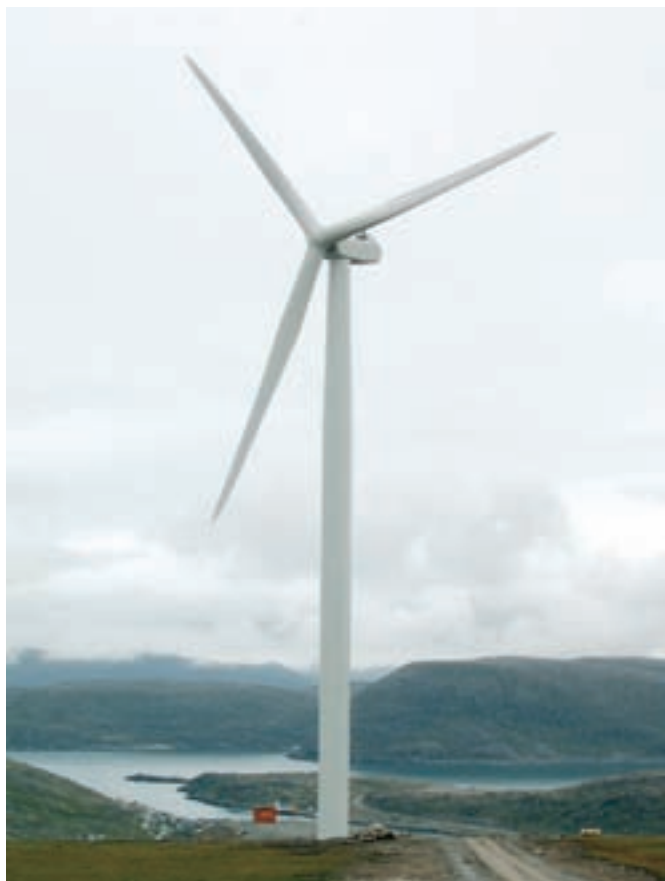
Fig.8 Vindturbin på Havøygavlen. Vindturbin fra Nordex, 2,5 MW. Tårnhøyde 80 m, rotordiameter 80 m
