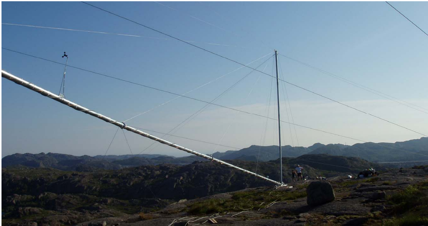
Figur 4.1. Reising av vindmålemast på Helleheia
