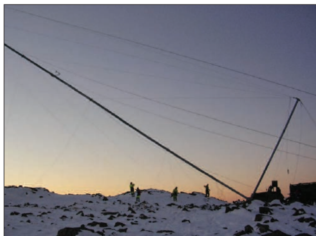
Heising av vindmålemasta på Bufjellet høsten 2005.
