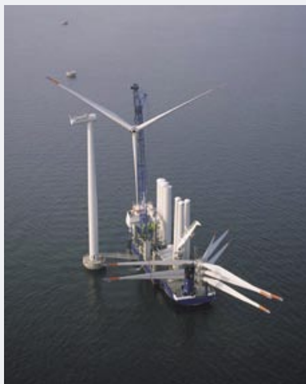
Spesialskip monterer vindturbiner. Lagringskapasitet på fire komplette turbiner ombord.
