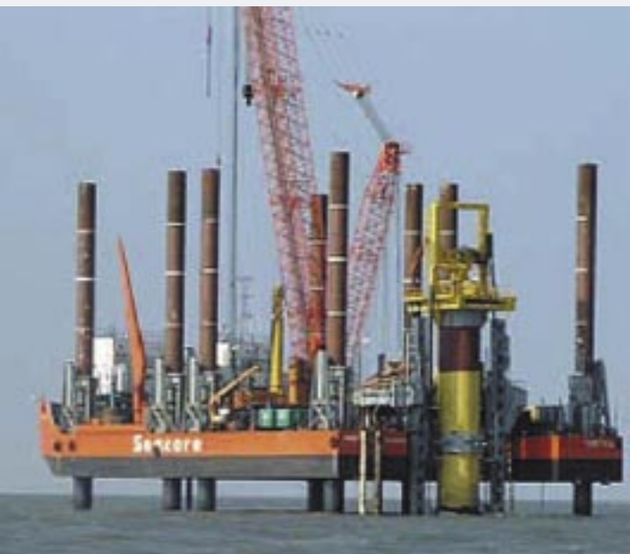
Oppjekkbar plattform kan benyttes i fbm fundamentering. her monteres fundamenter av typen mono piles
