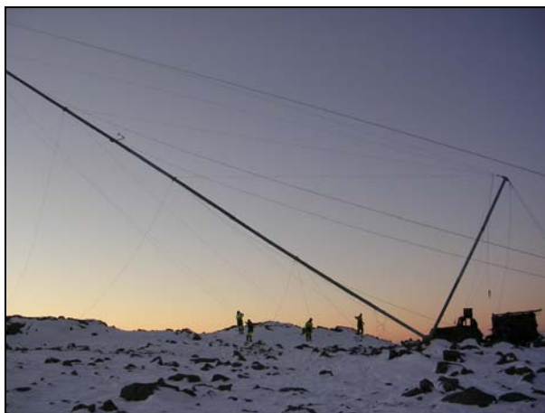
Bildet er tatt i forbindelse med montasjen av vindmålemast i Bø kommune sist høst.
