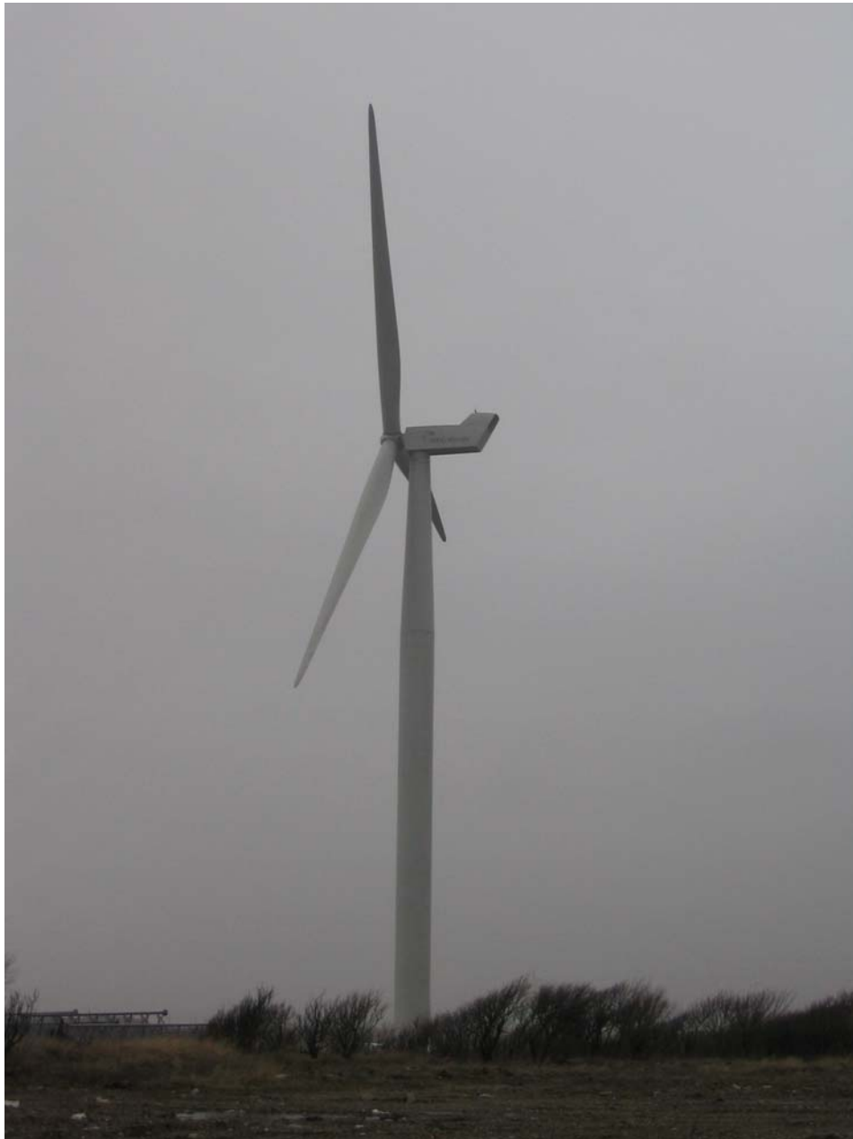
Fig.5: NEG Micon NM110 - 4.5 MW vindmølle på den danske testområde, Høvsøre. Møllen er utgått etter Vestas oppkjøp av NEG Micon.
