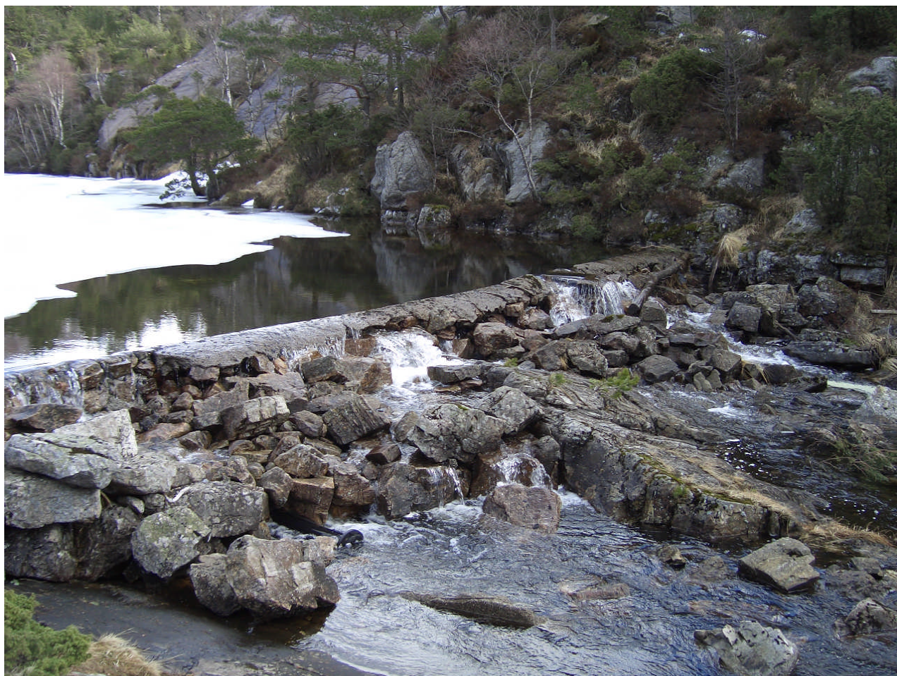
Fig 8: Eksisterende dam ved utløpet av Fossvatn
