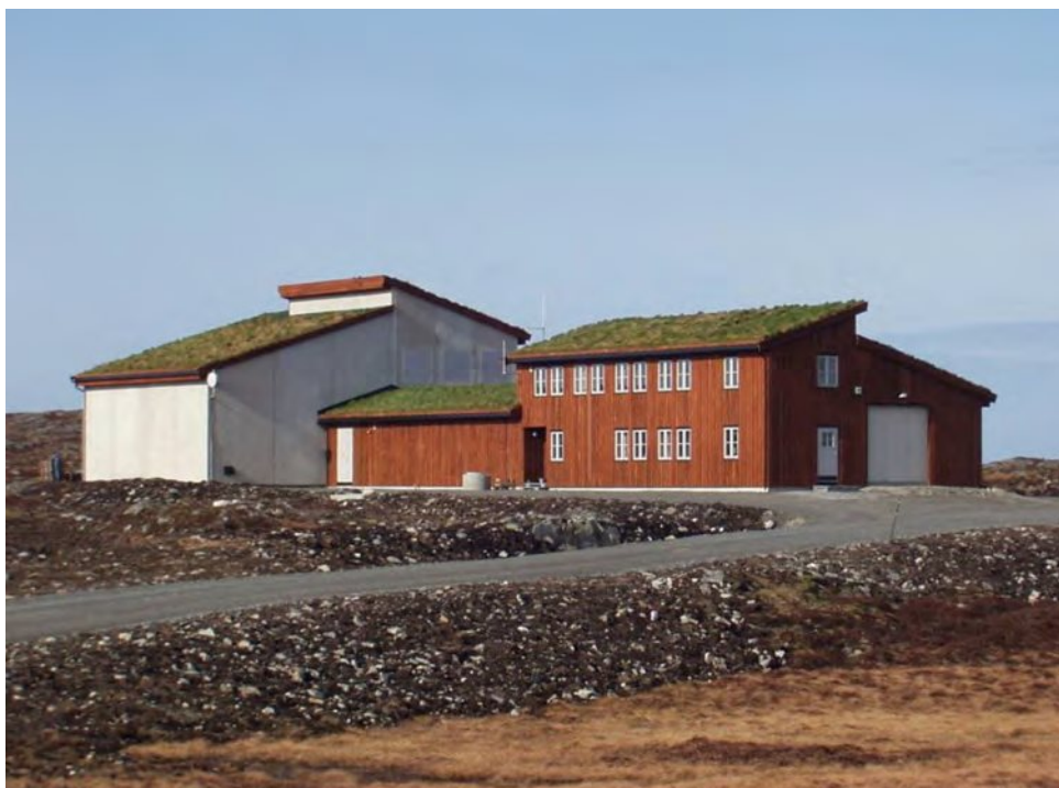
Figur 9. Eksempel på transformatorstasjon med servicebygg – Smøla vindkraftverk. Foto: Statkraft.
