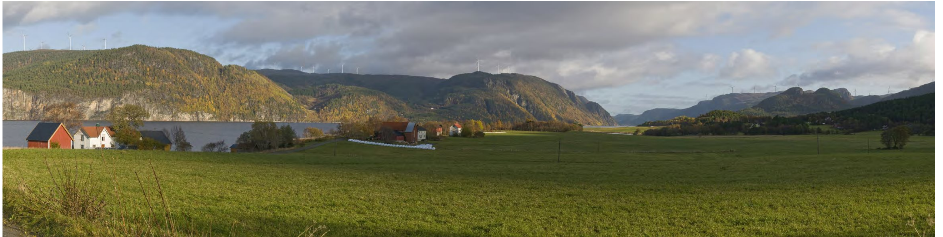
Geitfjellet vindkraftverk til høyre og Svarthammaren/Pållifjellet vindpark til venstre i bildet, sett fra Ytre Snillfjord.
