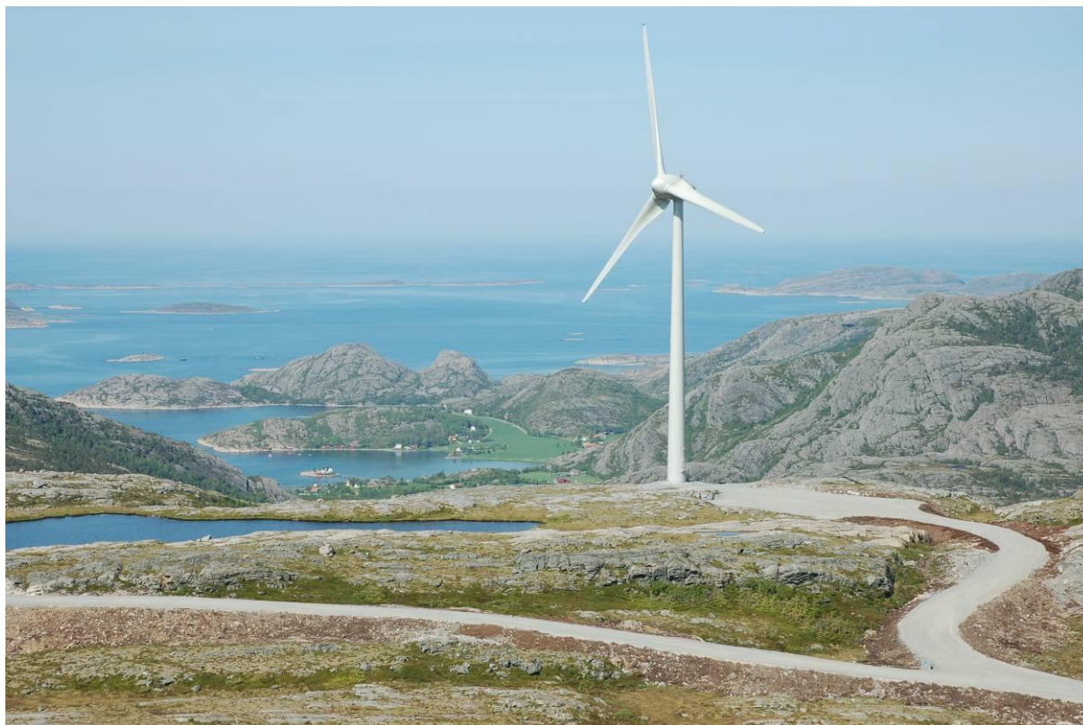
Figur 4. Eksempel på vindturbin, veg og kranoppstillingsplass. Tårnhøyde på viste 2,3 MW turbin er 64 m og rotordiameter 71 m. Foto: Ask Rådgivning
