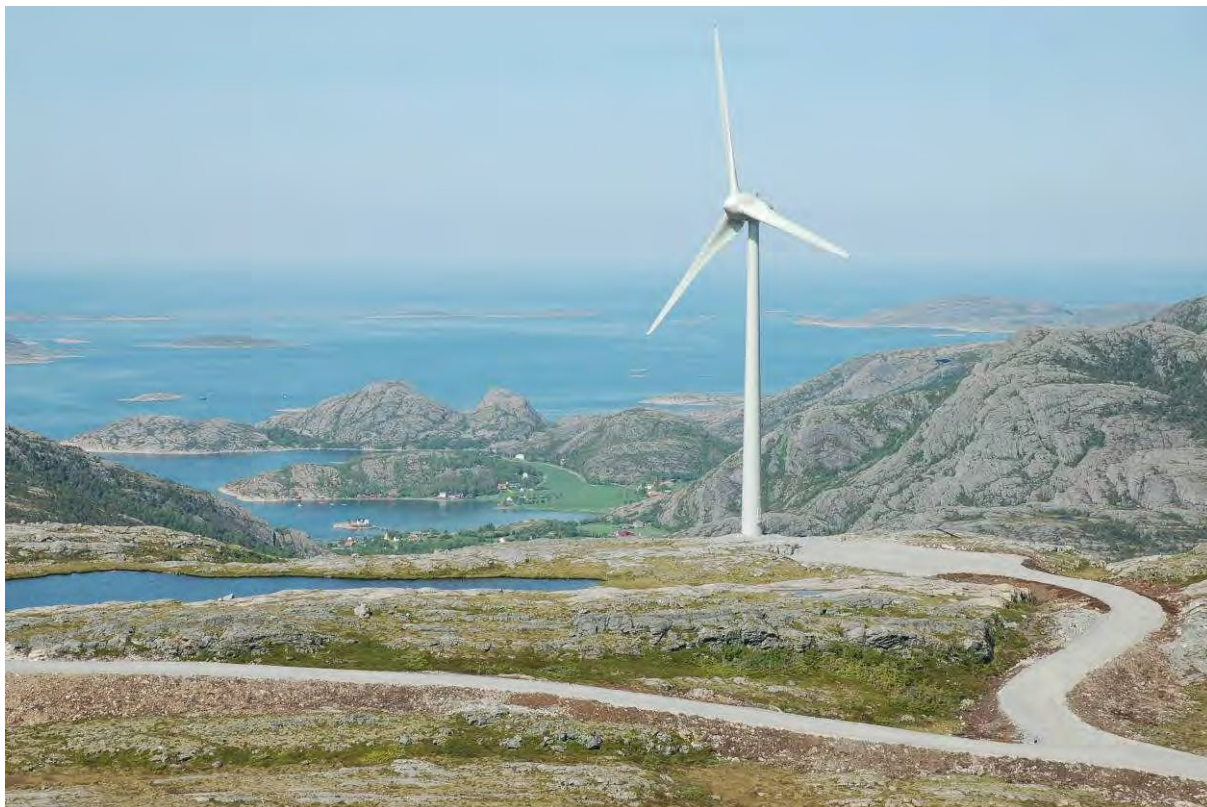
Figur 2 Eksempel på vindturbin, veg og kranoppstillingsplass. Tårnhøyde på viste 2,3 MW turbin er 64 m og rotordiameter 71 m. Foto: Ask Rådgivning
