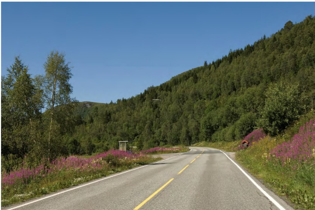
Figur 21: Adkomstvei alternativ 3 vil ta av fra riksveien rett bortenfor avkjørselen og gå i skrålia vestover. Det kan bli en del skjæring og fylling, men inngrepene dempes visuelt en del av skogen rundt. Foto: Svein Erik Dahl
