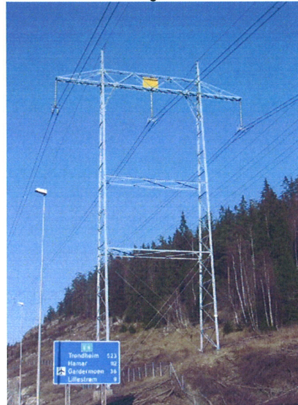
Figur 3.4.1 Typisk mastebilde for 300 kV mast
