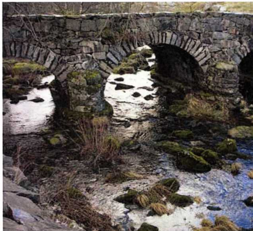
Sokkakjersbrua. Foto: Jan Stokkeland
