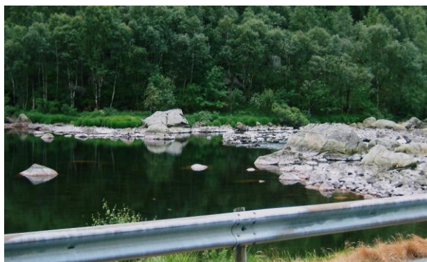
Utløpet av Hølen-inntaksområdet for Åmot kr.verk
