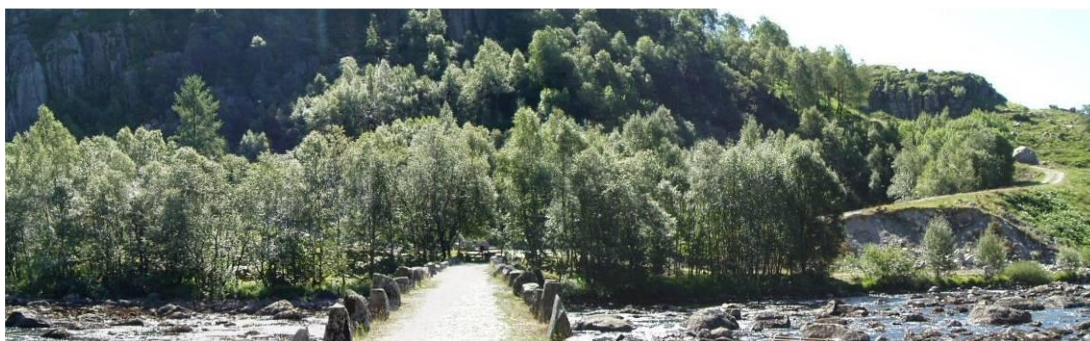
Figur 5-6. Vegvesenet har et massetak til venstre og høyre for sørenden av Terland klopp. Vegetasjon i forgrunnen skjuler dette skjemmende inngrepet. Foto: I. Biørnstad.
