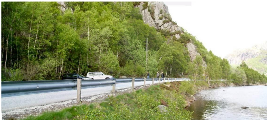
Figur 6-10. Område for lukehus og inntak ved RV 42, Hølen. Sammensatt bilde. Foto: I. Bjørnstad.
