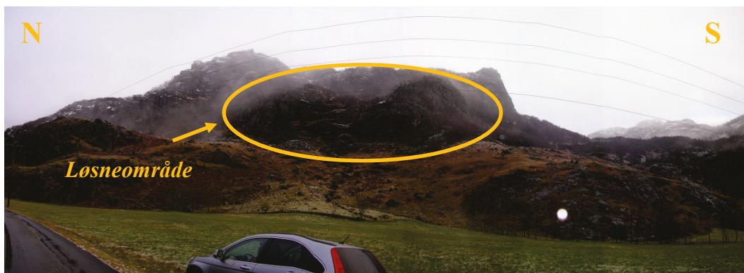
Figur 14. Riggområde nr. 5, området mot Gya kraftverk. Potensielt løsneområde for steinsprang er vist.
