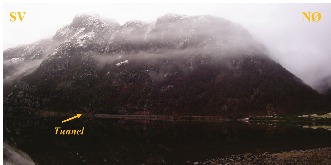
Figur 10. Tippetområde nr. 1, området mot Gya kraftverk.
