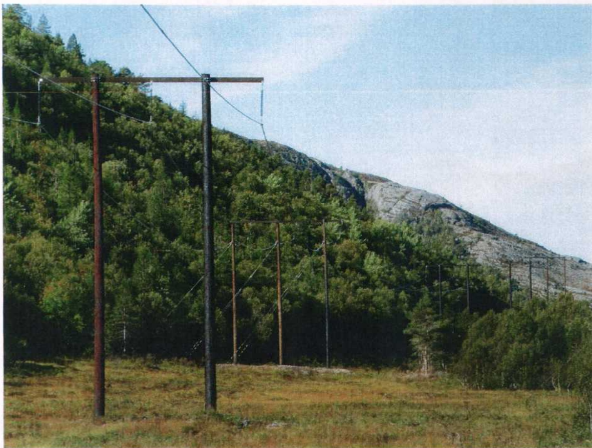
Typisk mastebilde 132 kV (bilde gjengitt med tillatelse fra El-tjeneste AS)
