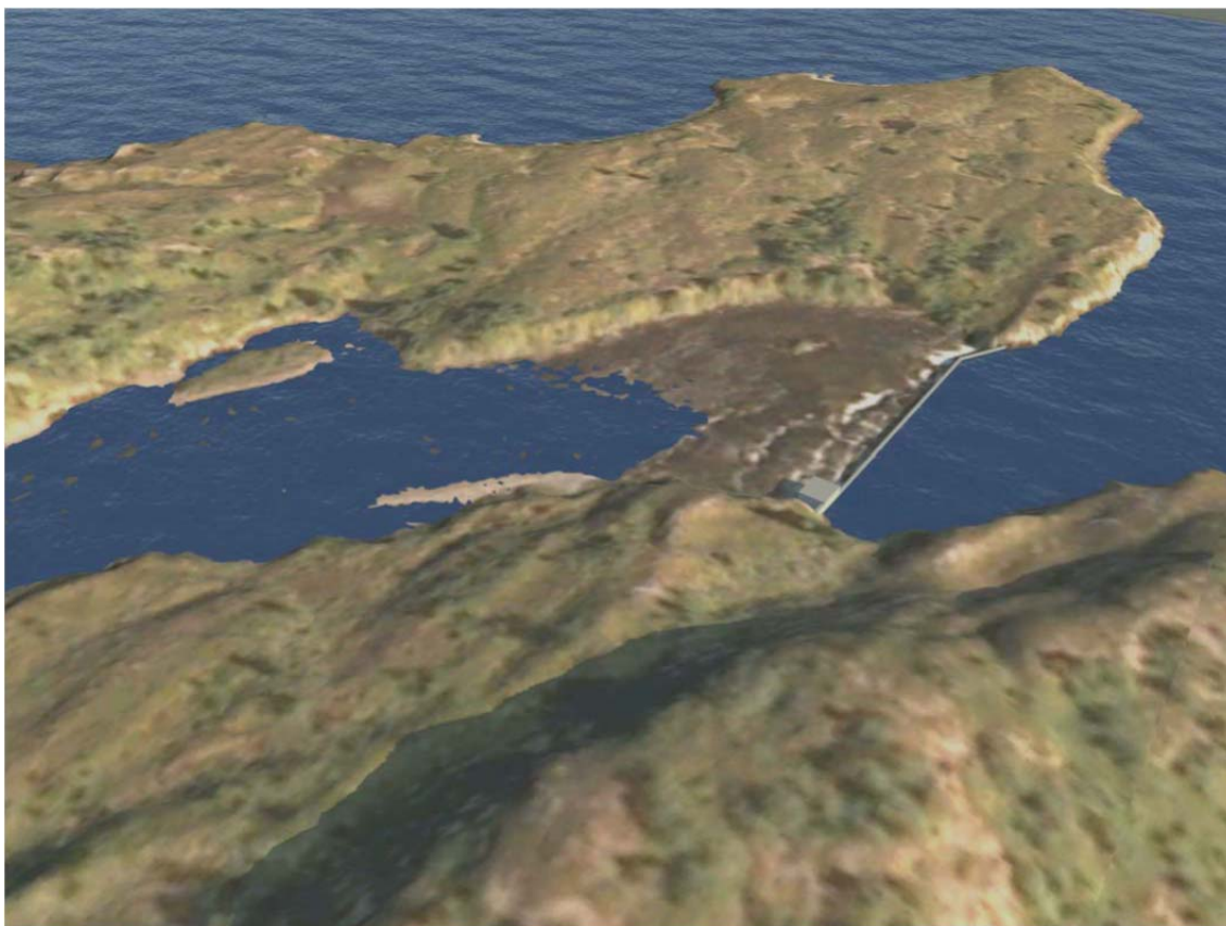
Figur 2 Visualisering av terskel med slipp av minstevannføring ved utløpet av Krutvatnet. Sett fra vest.
