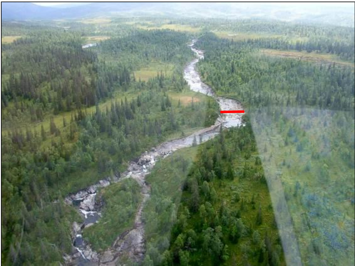
Inntaksområdet sett ovenfra, fra nedstrøms side. Dammen illustrert med rødt.
