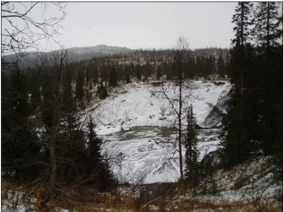
Store erosjonsskader i løsmasselaget på østsiden av elva.
