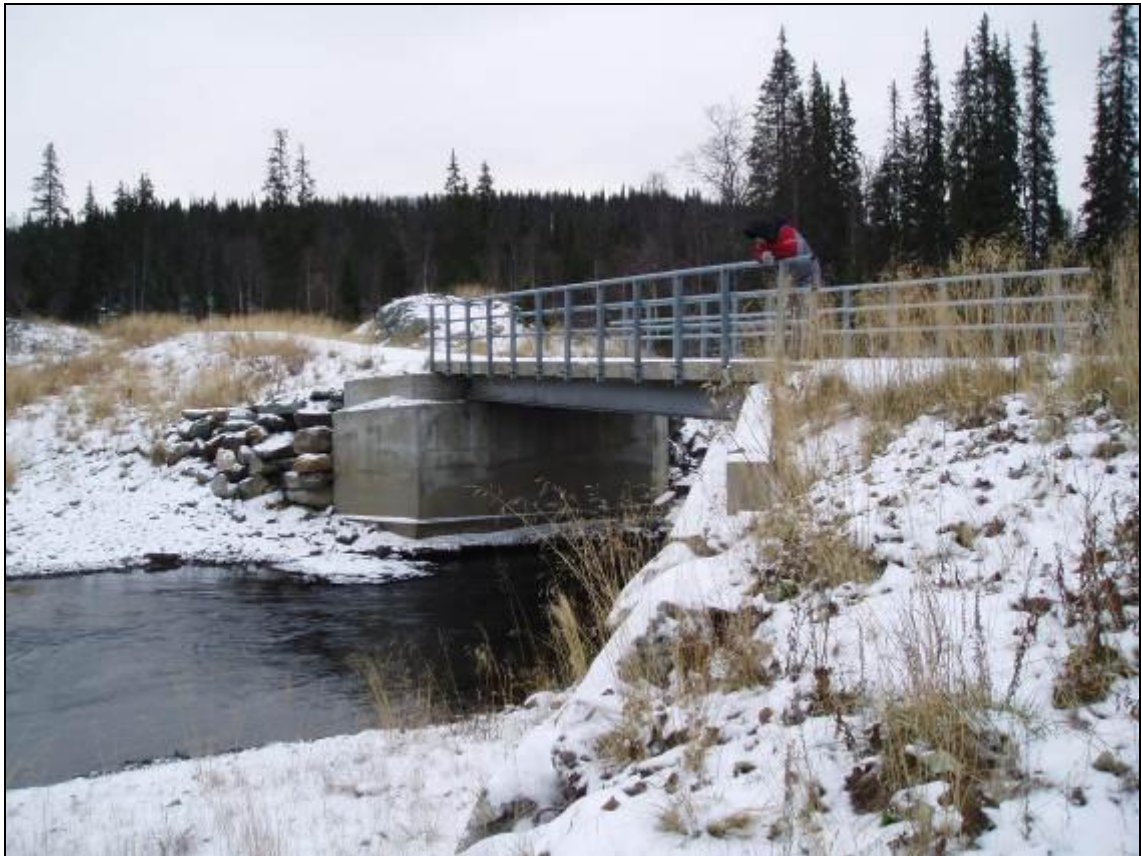
Brua over utløpet fra Stemtjørna.
