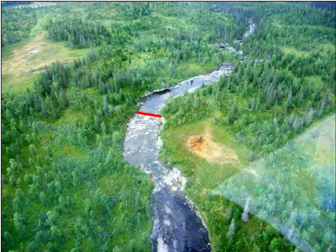
Inntaksområdet sett ovenfra, fra oppstrøms side. Dammen illustrert med rødt.
