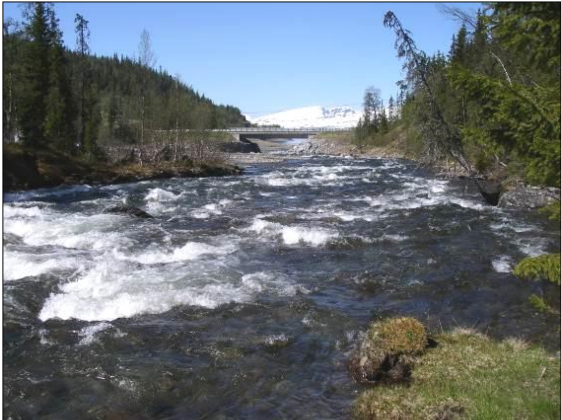
Sett fra stasjonsområdet i retning riksveien og Røssvatnet.
