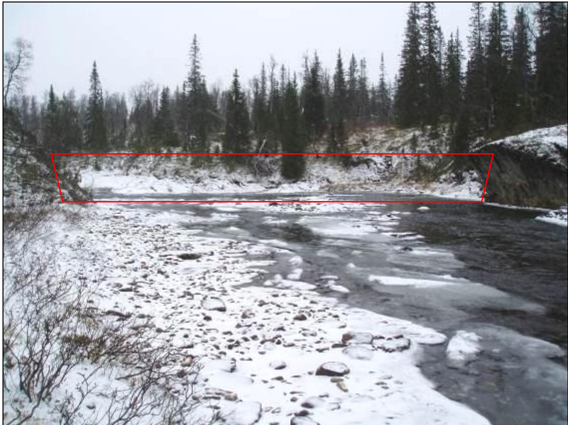
Damstedet sett fra nedstrøms side. Dammen illustrert med rødt.
