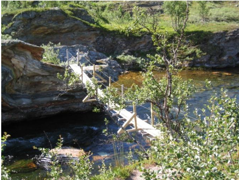
Figur 7-35: Hengebru over Krutåga på turstien opp mot Hjeltfjellvatnet.
