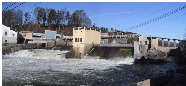
Dam og flomluker
