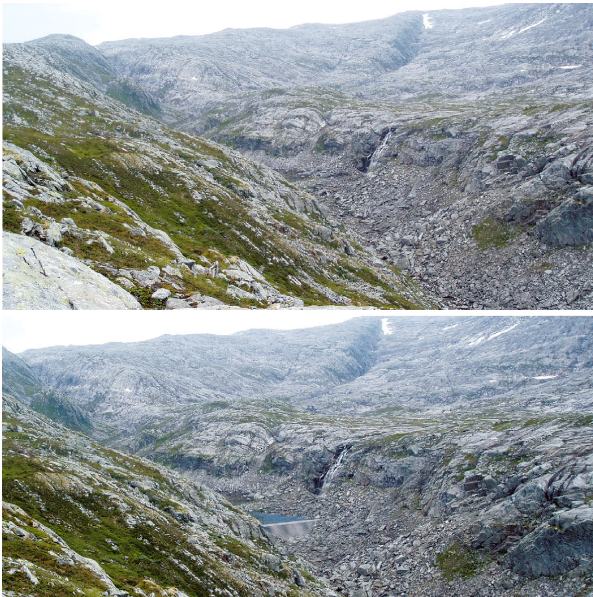
Figur 4.19. Fotoillustrasjon av inntaksstedet i Sørelva før (øverst) og etter bygging av inntaksdam.
