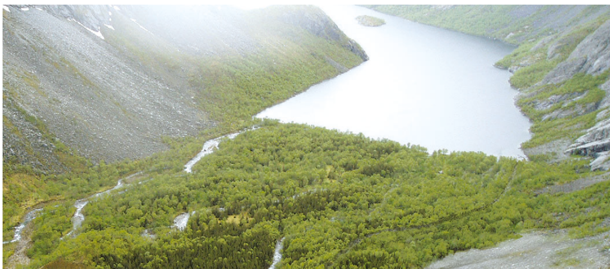
Figur 4.20. Illustrasjon av Vassenden sett fra Vassendhella før (øverst) og etter en utbygging.
