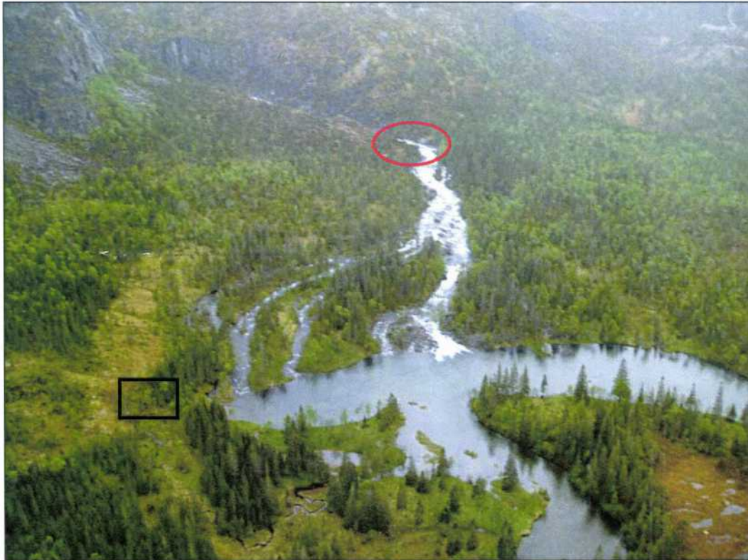
Figur 3 Kraftstasjonsområdet og Forslandselva. Kraftstasjonen er markert med svart firkant, mens elvekryssing i form av bru er markert med rød sirkel. Bildet er tatt fra helikopter.
