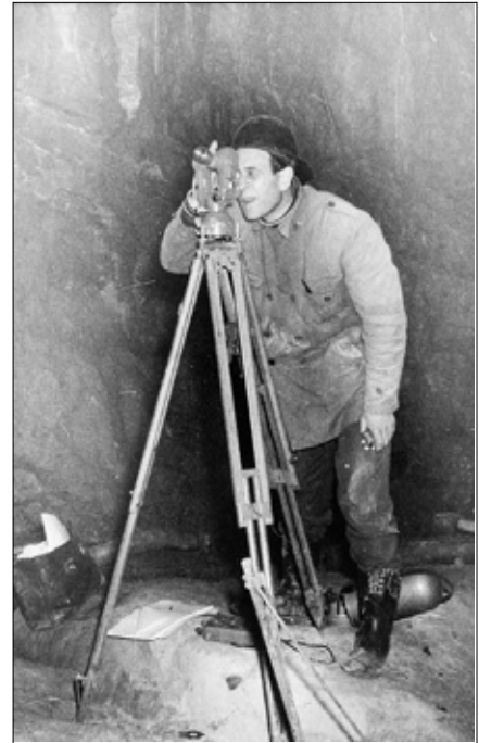
Foto 1: A. Sommerli i arbeid på Røssågaanlegget.
