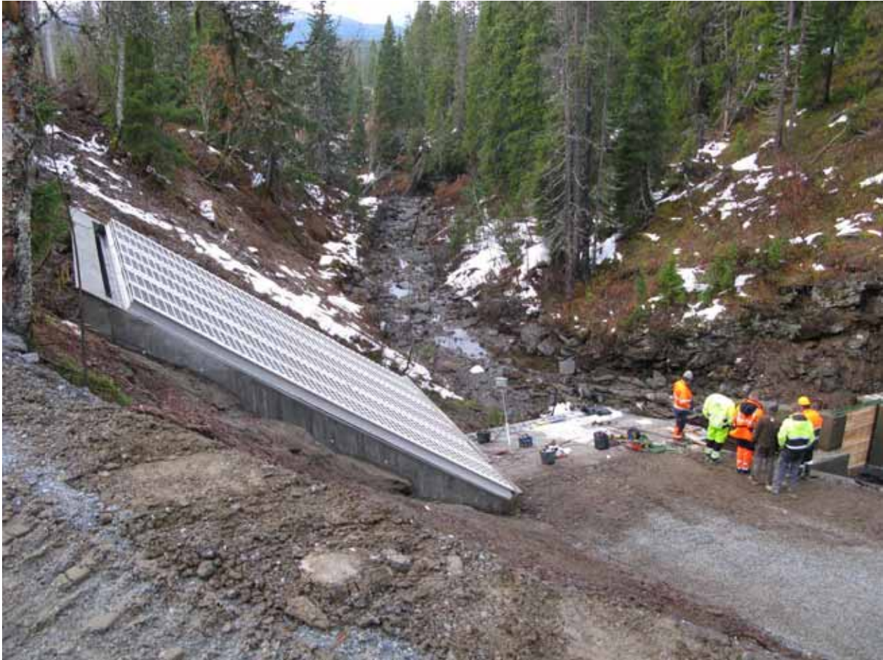
Foto 16 Sikringen av bekkeinntak. Inntakskonstruksjonen i Storbekken er sikret for mennesker og dyr.
