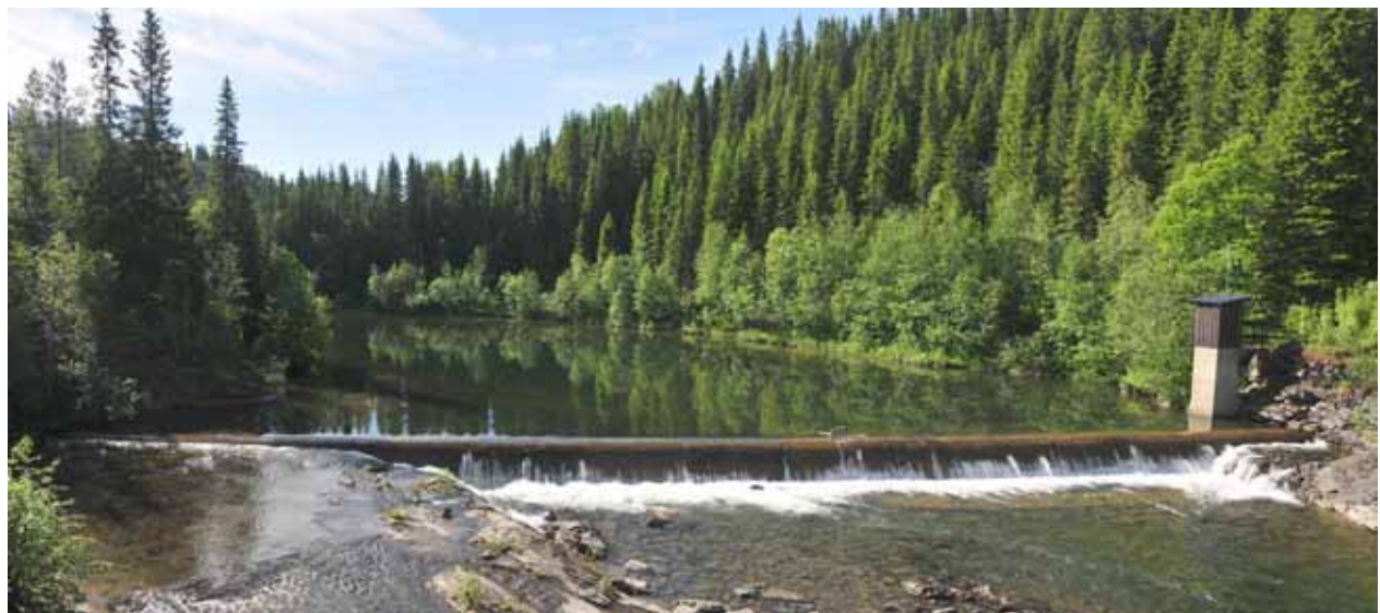
Foto 9 Terskel og målestasjon i Røssåga, ovenfor Sjøforsen.
