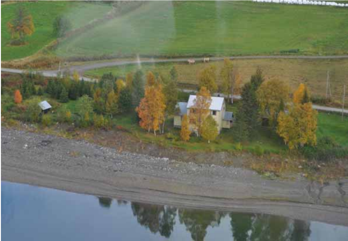
Foto 10 Varntresk. Etter at tiltak ble utført i 2008. Området nedenfor huset var i ferd med å erodere bort. Kanten er forsterket med stein og påført vekstmasser.
