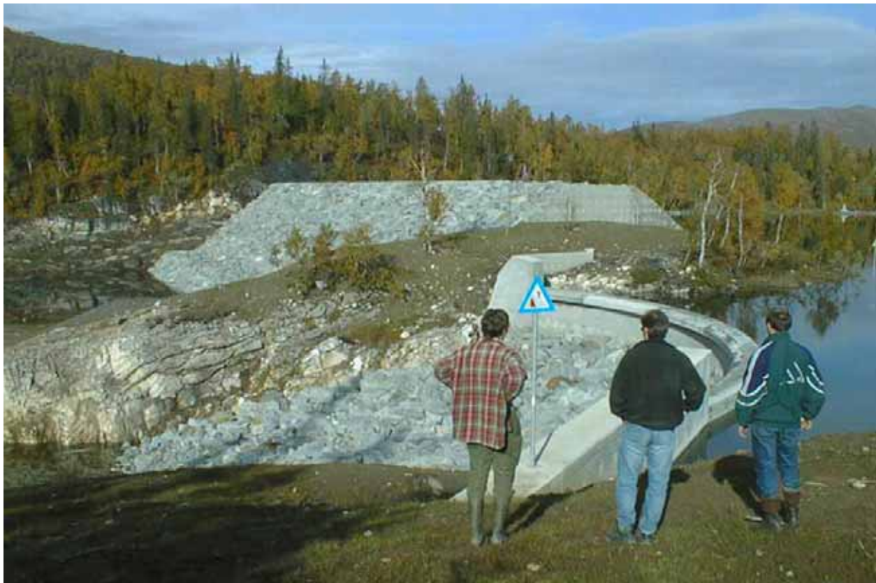
Foto 3 Bleikvassdammen. Steinfallingsdam og overløpsterskel
