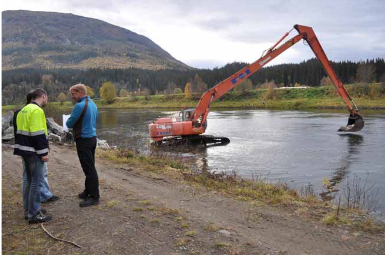
Foto 18 Utlegging av stein i Røssåga startet opp høsten 2010. På sikt skal dette gi bedre forhold for lakseyngel
