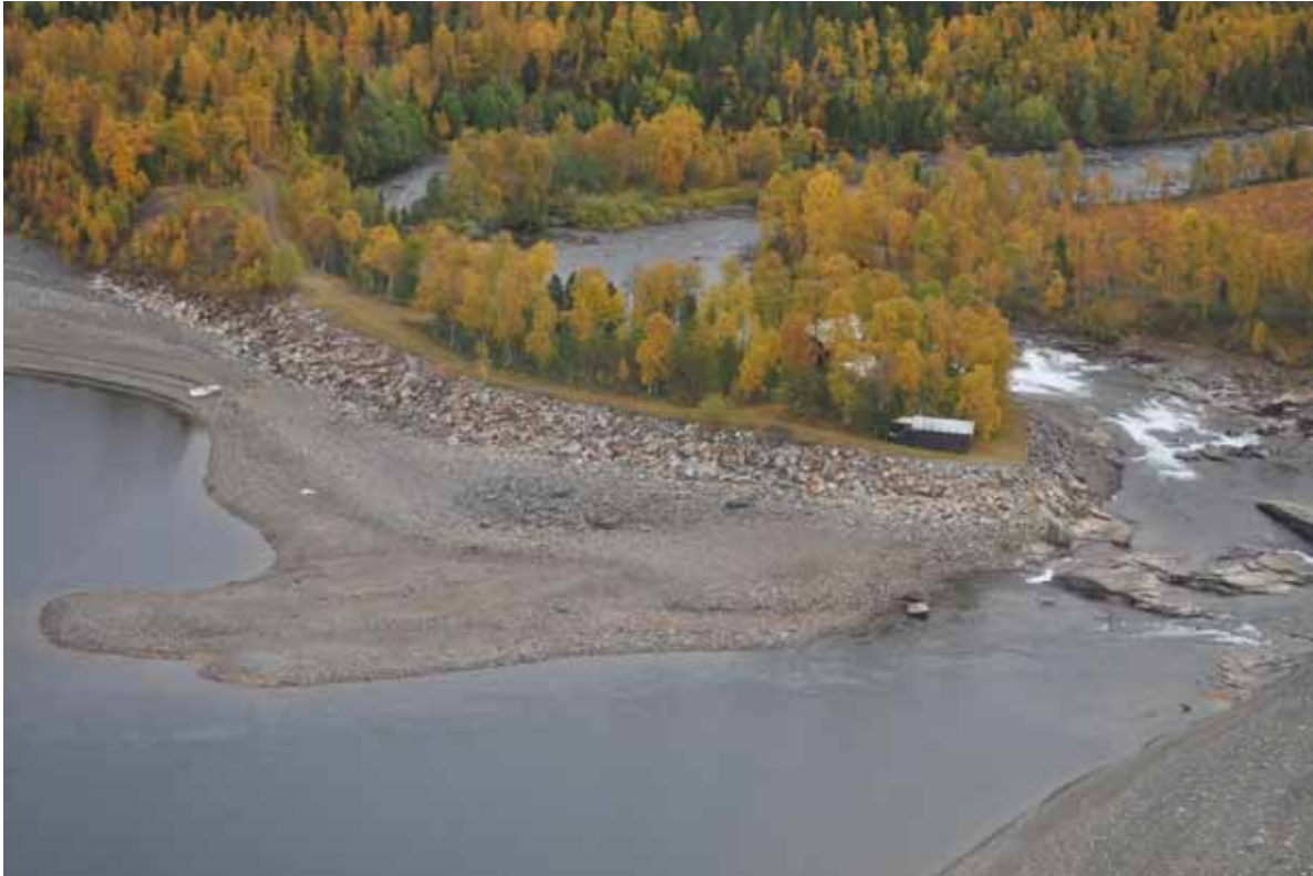
Foto 11 Typisk erosjonssikring i strandsonen av Røssvatnet. Her fra innløpet av Krutåga til Røssvatnet.
