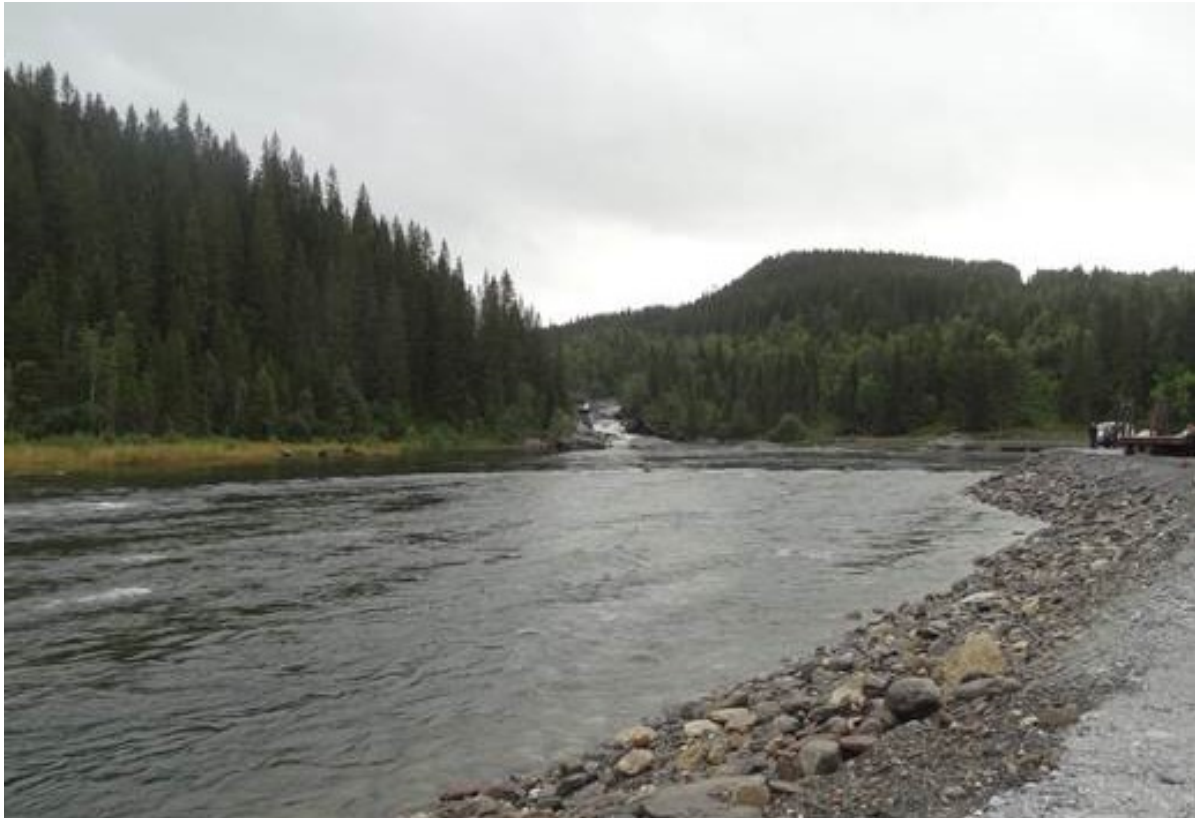
Figur 3 Øverste del av restaurert elvestrekning, sett mot Sjøforsen og nytt kraftverksutløp øverst til høyre. Fra befaring 31. august 2016.
