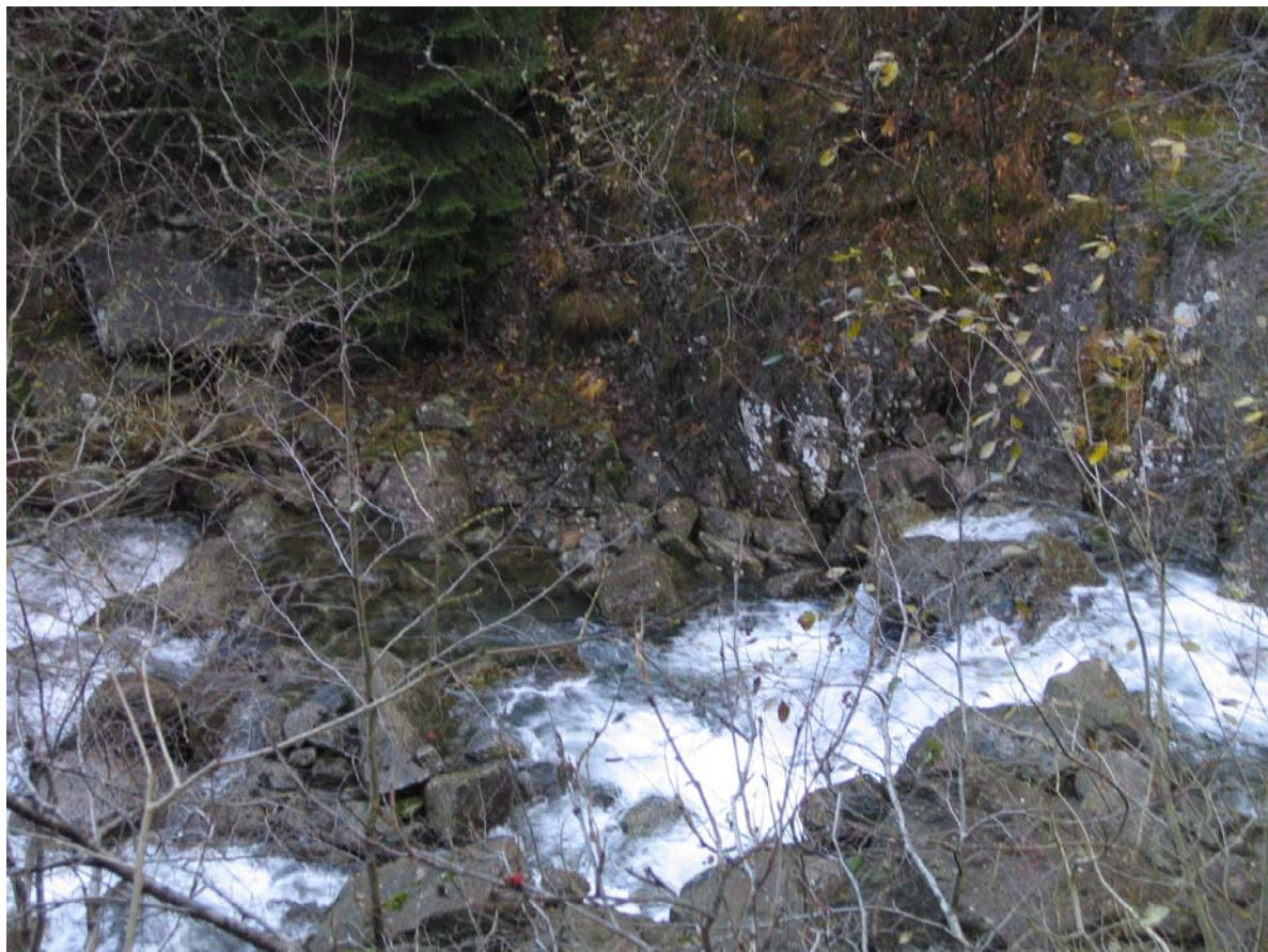
Oversikt fra inntaksstedet
