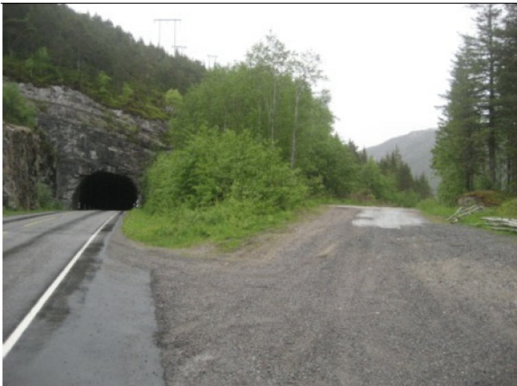
Figur 5.2 Tunnel og den gamle veien ved Mørre kraftverk
