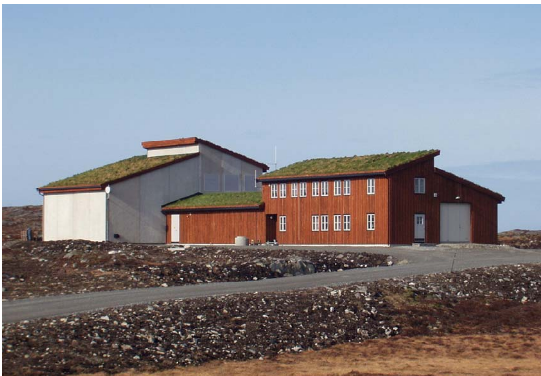
Figur 6.5 Transformatorstasjon og servicebygg (eksempel fra Smøla vindpark)
