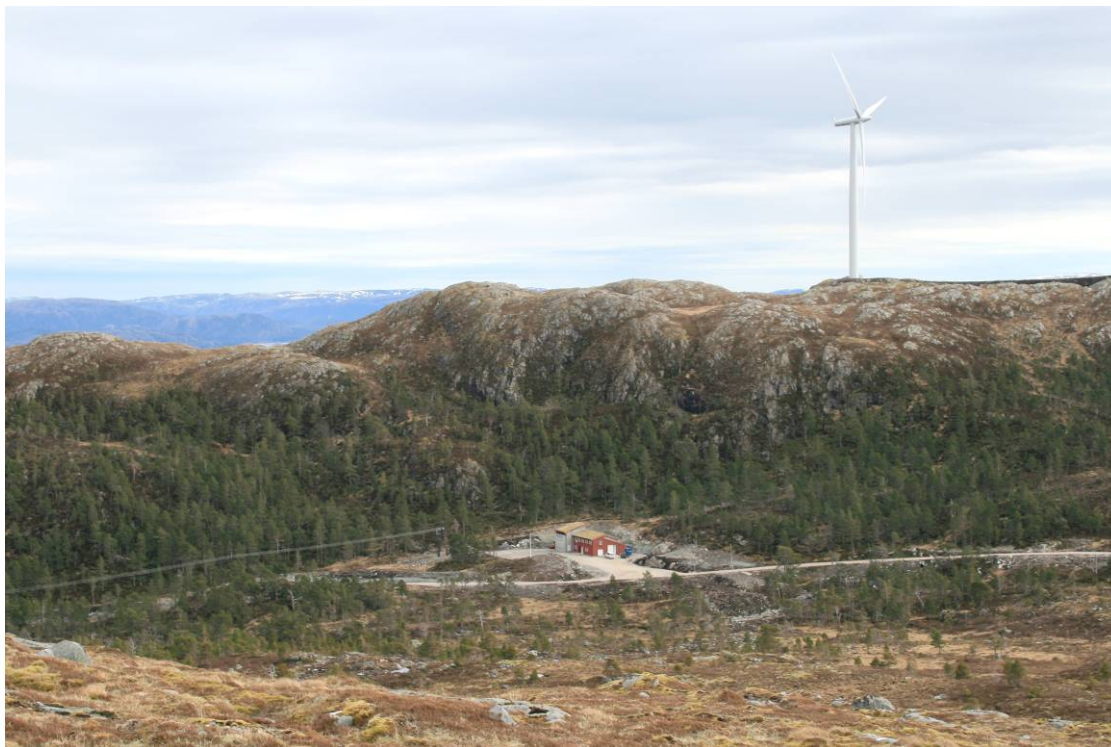
Figur 4.22: Atkomstvei og transformatorstasjon i Hitra vindpark. Eksempel på en transformatorstasjon som er godt tilpasset landskapet. Foto: Trond Simensen
