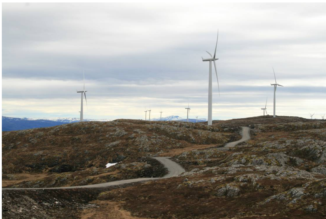
Figur 4.188: Interne veier i Hitra vindpark. Foto: Trond Simensen.
