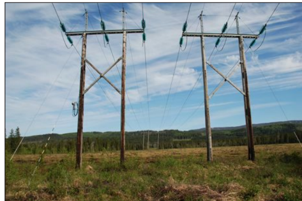
Parallele 66kV-ledninger
