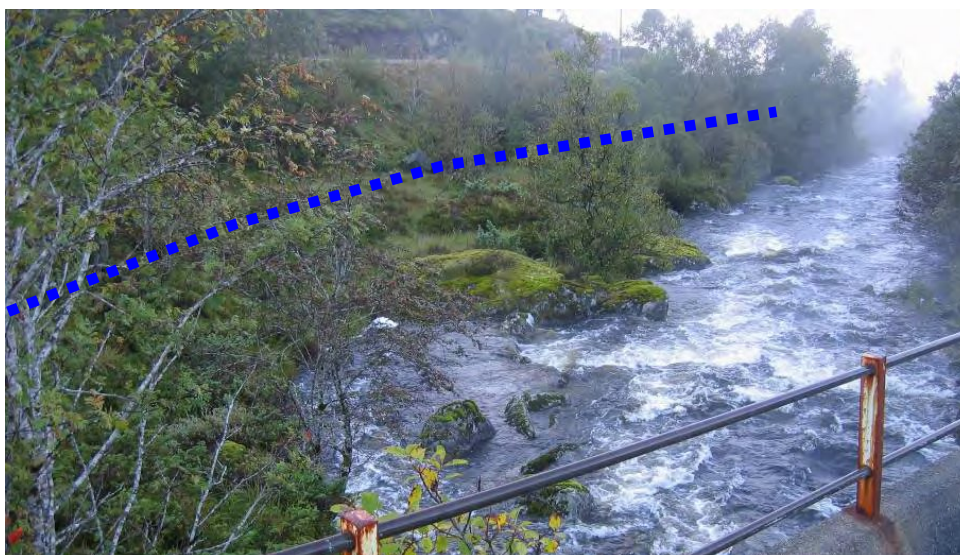
Figur 7 Rørtraseen langs Maurstadelva like nedstrøms utløpet av Navevatnet.
