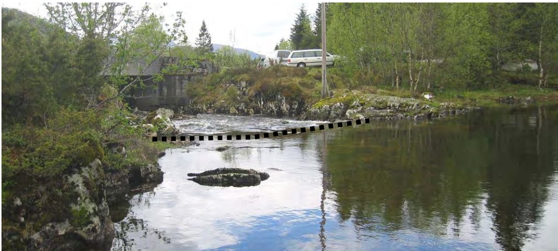
Figur 7 Utløpet av Navevatnet. En lav betongterskel er planlagt etablert om lag langs den stiplede linjen. Videre etableres arrangement for slipping av minstevannføring samt arrangement som gir passeringsmulighet for fisk.
