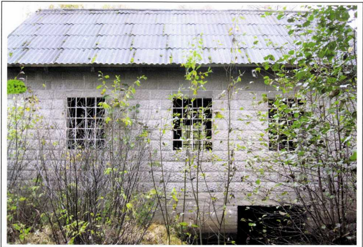
Kraftverksbygningen sett fra utløpssiden.
