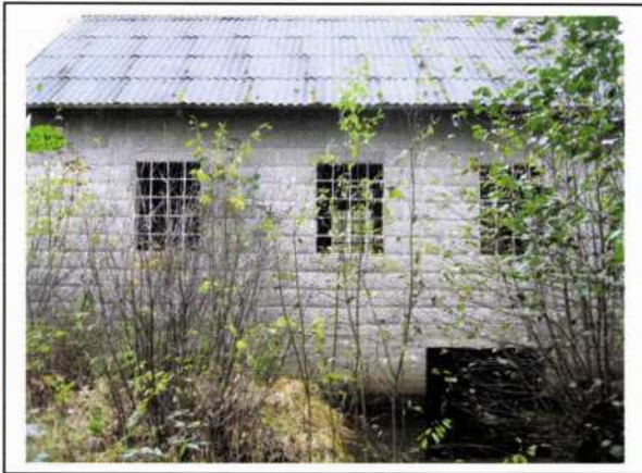
Vestvegg av kraftverksbygning i dag. Åpningen under huset er utløpet fra turbinen.
