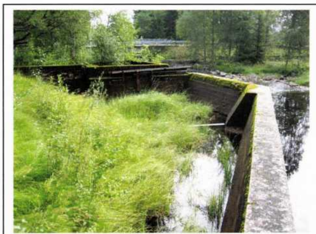
Inntaket sett fra baksiden.
