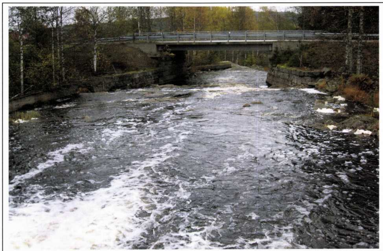
Brua over Veståa sett fra damkrona og østover.
