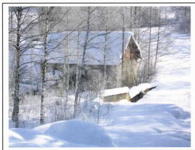
Kraftverksbygningen, og åa nedenfor riksvei 410.
