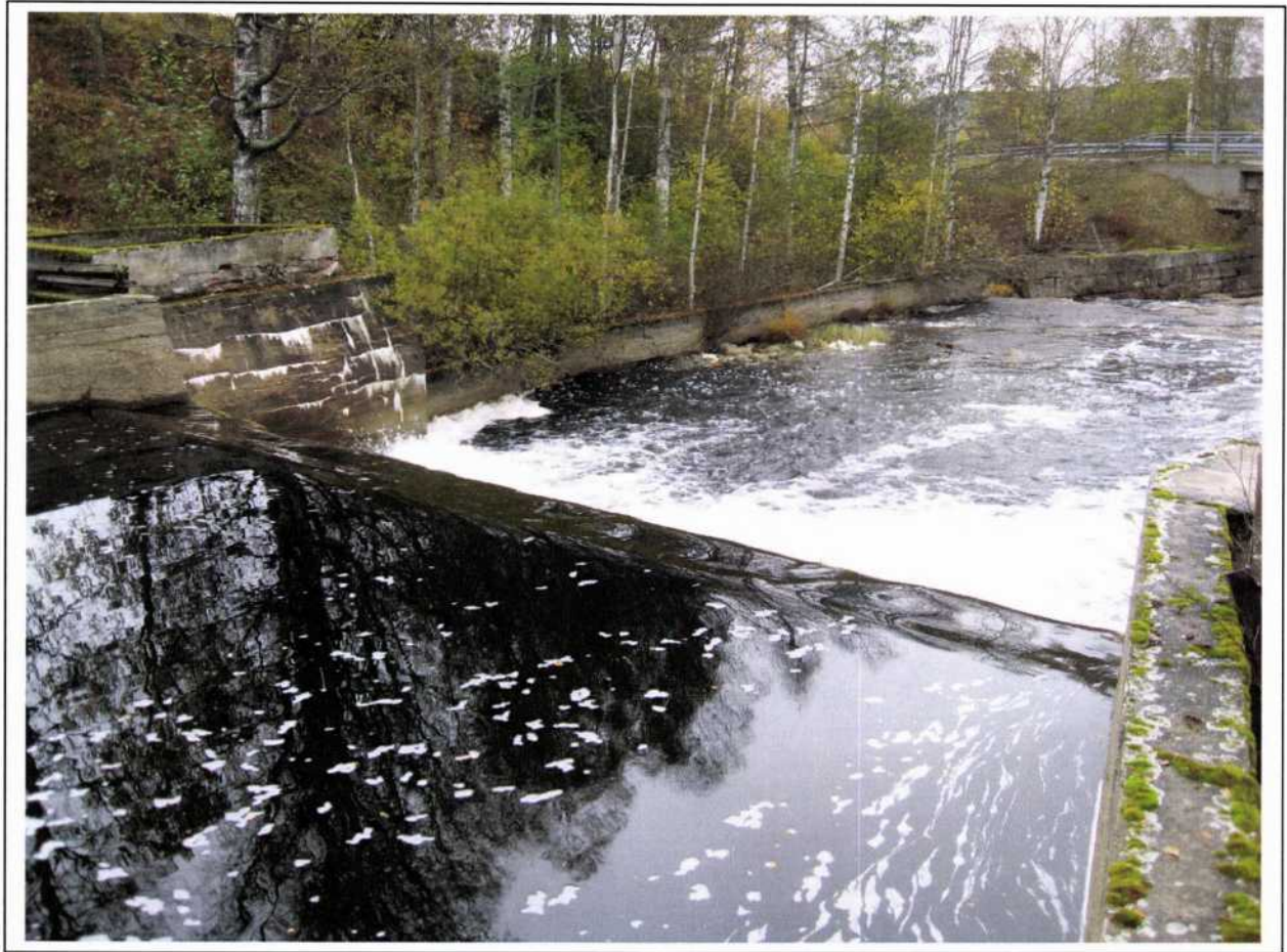
Overløpet til dammen
