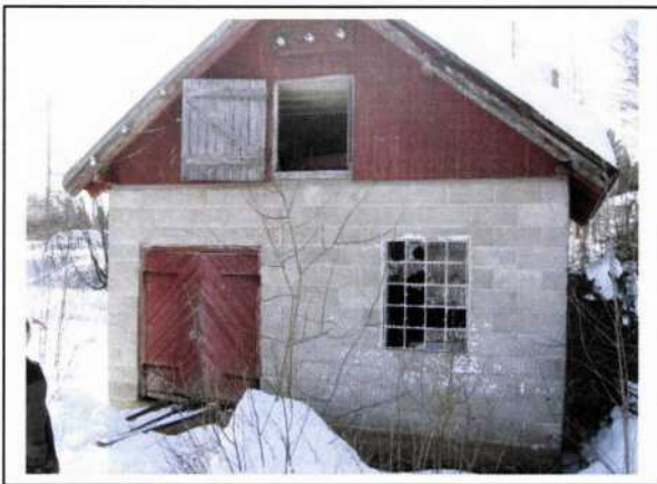
Bygningen sett fra nord.
