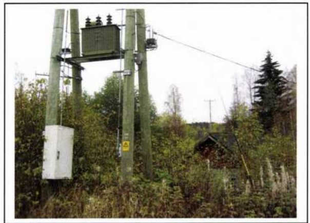
Bygningens plassering i forhold til transformator.
