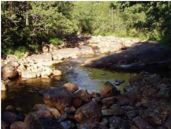
Bilde 3.2: Ved planlagt avløp til kraftverket ved utløpet av Skarkebekk 19. juli 2006
