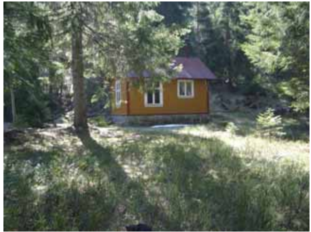
Bilde 13: Nedlagt kraftstasjon ved fossen nedenfor Kilå bru.
