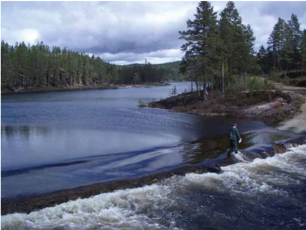
Figur 2.2.6: Inntaket vil bli plassert i bakkant av neset som en ser midt i bildet.
