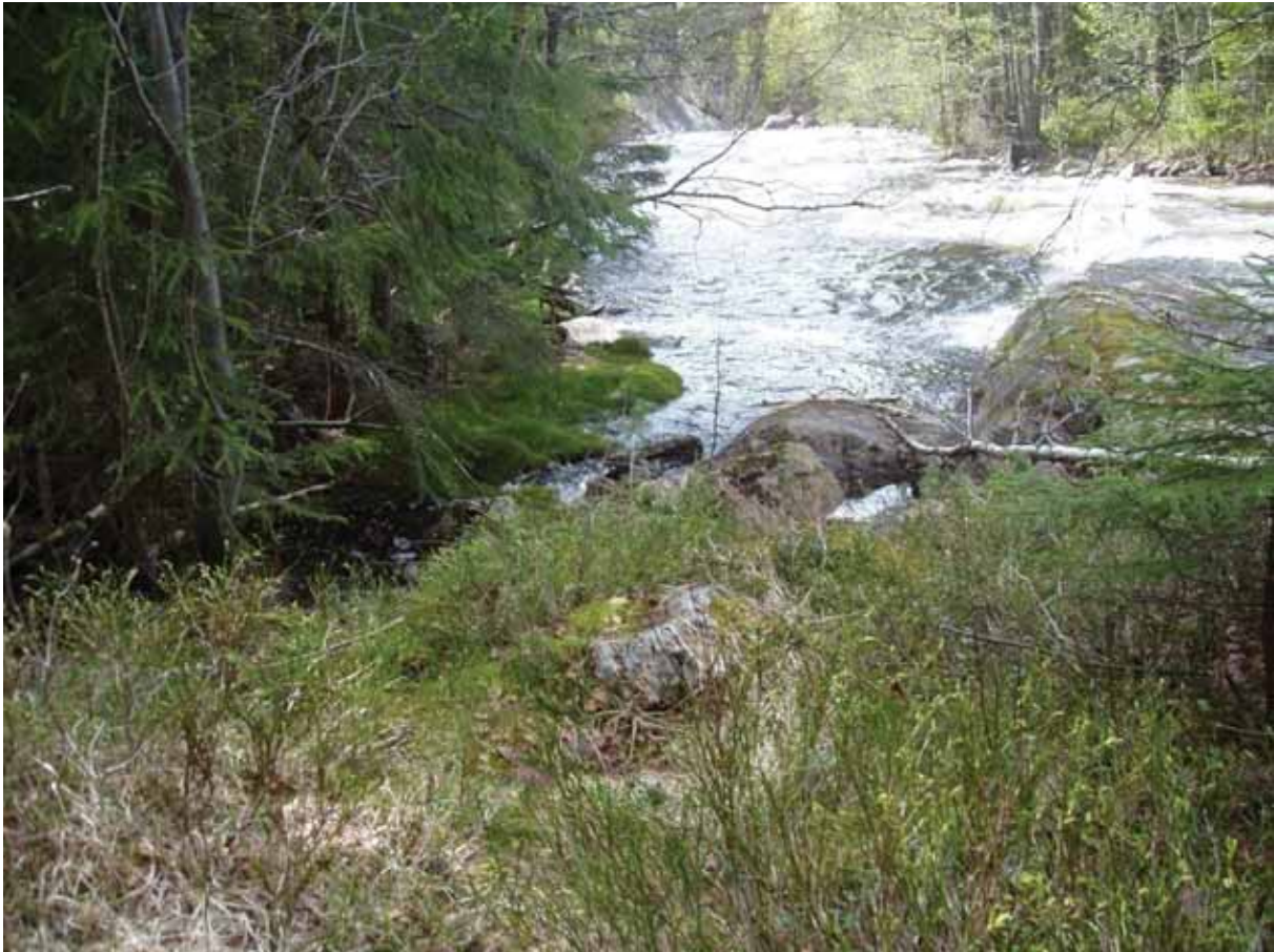
Figur 2.2.7: Kraftstasjonens avløp ved utløpet av Skarkebekk
