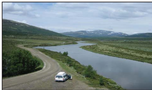
Einunndalsvegen mot vest
