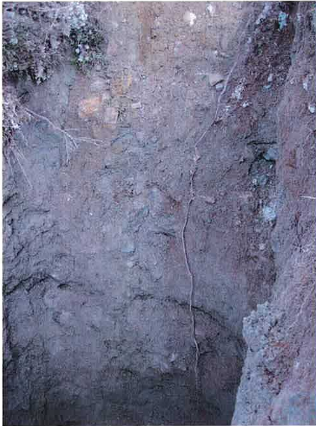
Sjakt 4 m dyp, øvre del
