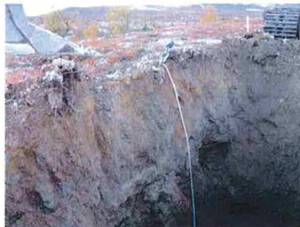
Sjakt 4 m dyp, øvre del
