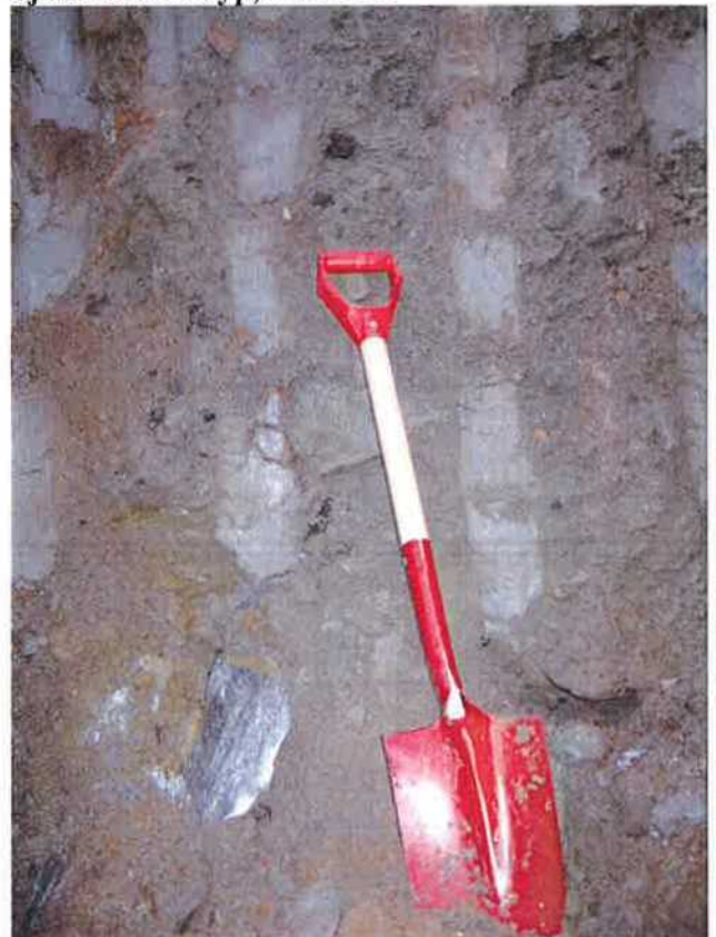
Sjakt ca. 2 m dyp, nedre del
