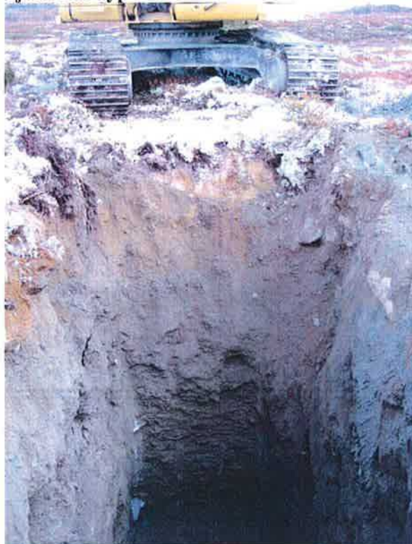
Sjakt 4 m dyp, øvre del
