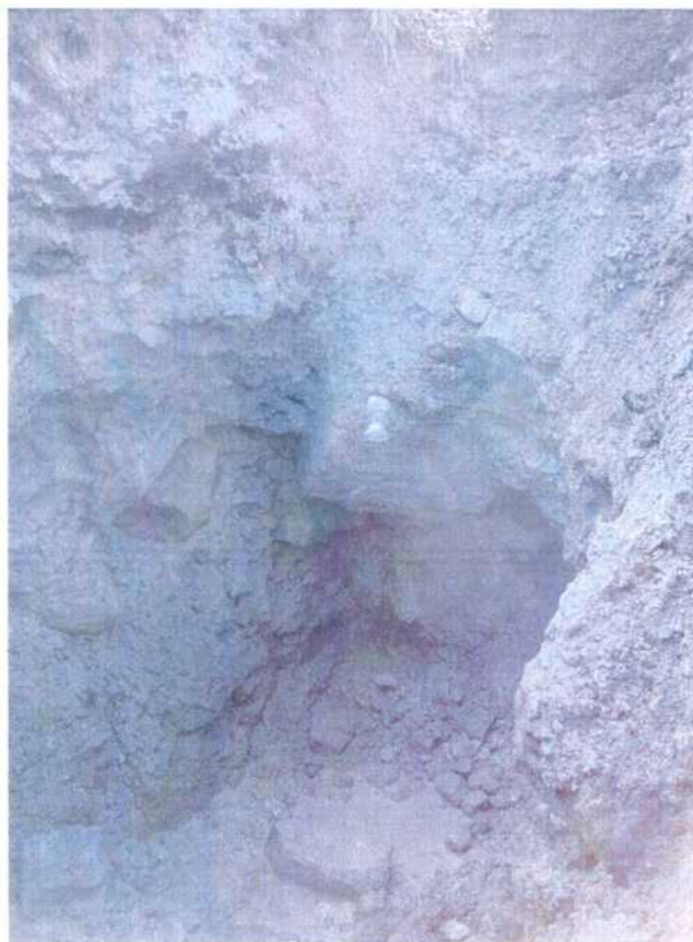
Stor blokk (ca. 1 m brei) i sjaktveggen skaper overheng og ras i underkant.
