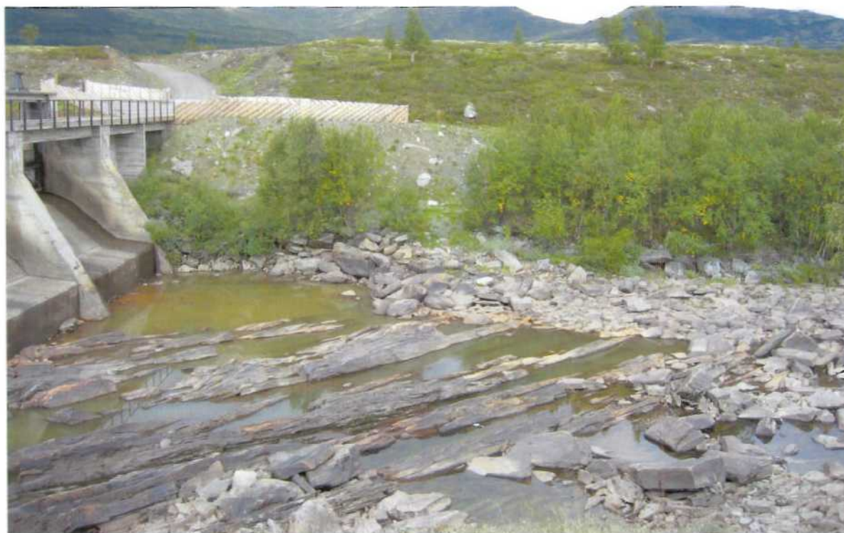
Figur 6 Skiferbergarter ved inntaksdam
