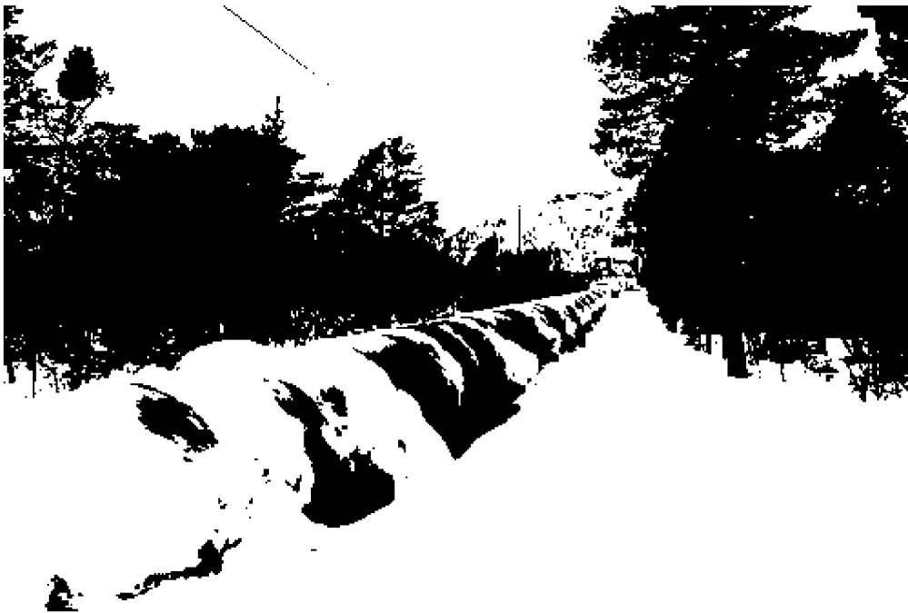
Rørgate fra Markbulidammen til Einunna kraftverk.
