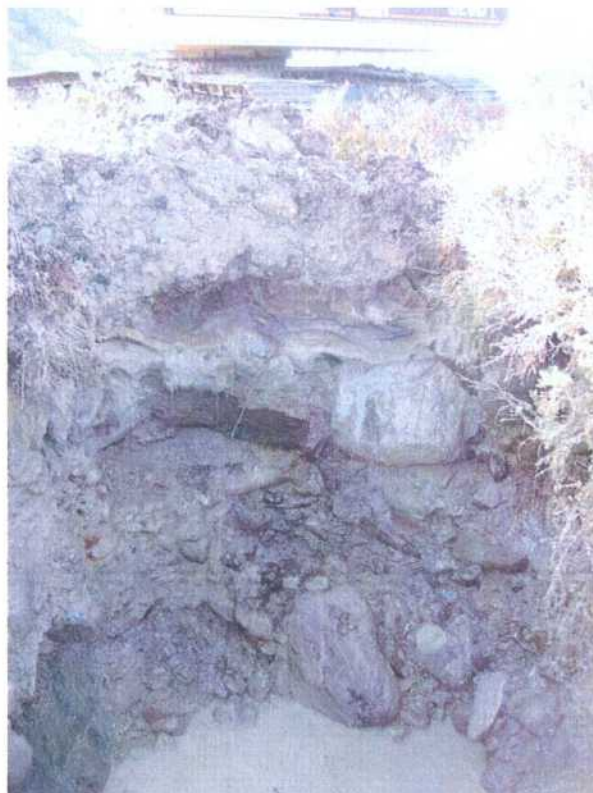
Sjakt, vannfylt ved ca. 3 m dyp
