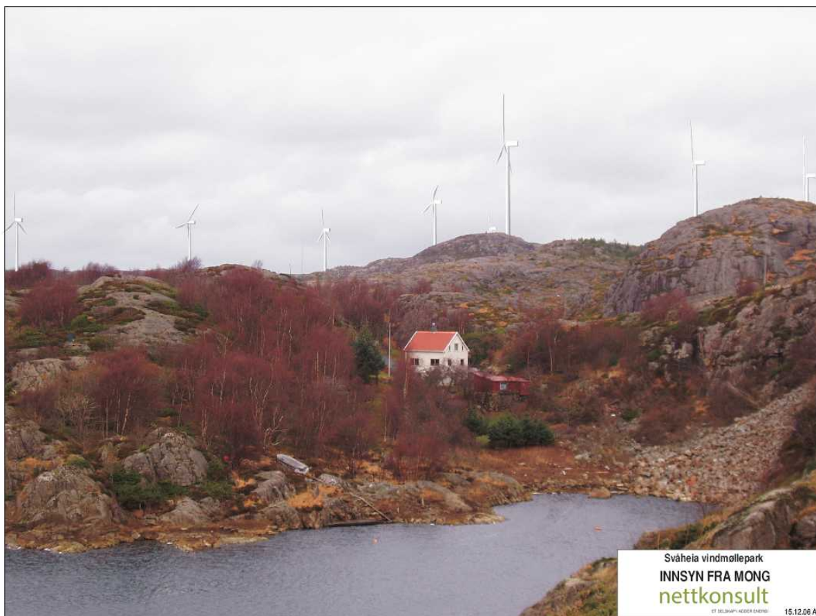
Figur 8 Vindkraftanlegget med 8 turbiner sett fra Mong
