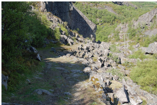
Oppbygging av veien
