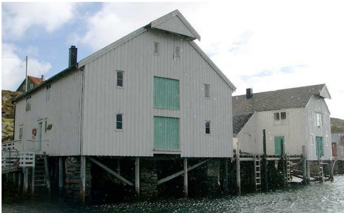
To brygger i Annsteinsundet er godt bevart. Her fantes en butikk som er godt bevart. (foto hentet fra Fylkesmannen i Sør-Trøndelag 2006: Oppfølging av særlig verdifulle kulturlandskap i Sør-Trøndelag )
