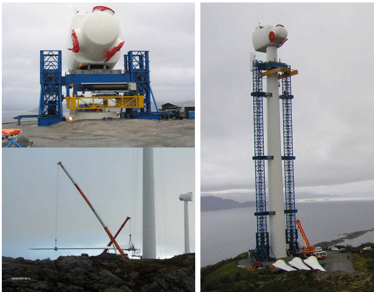
Figur 14 Oppsetting av vindturbin ved hjelp av løftetårn (foto: NTE)
