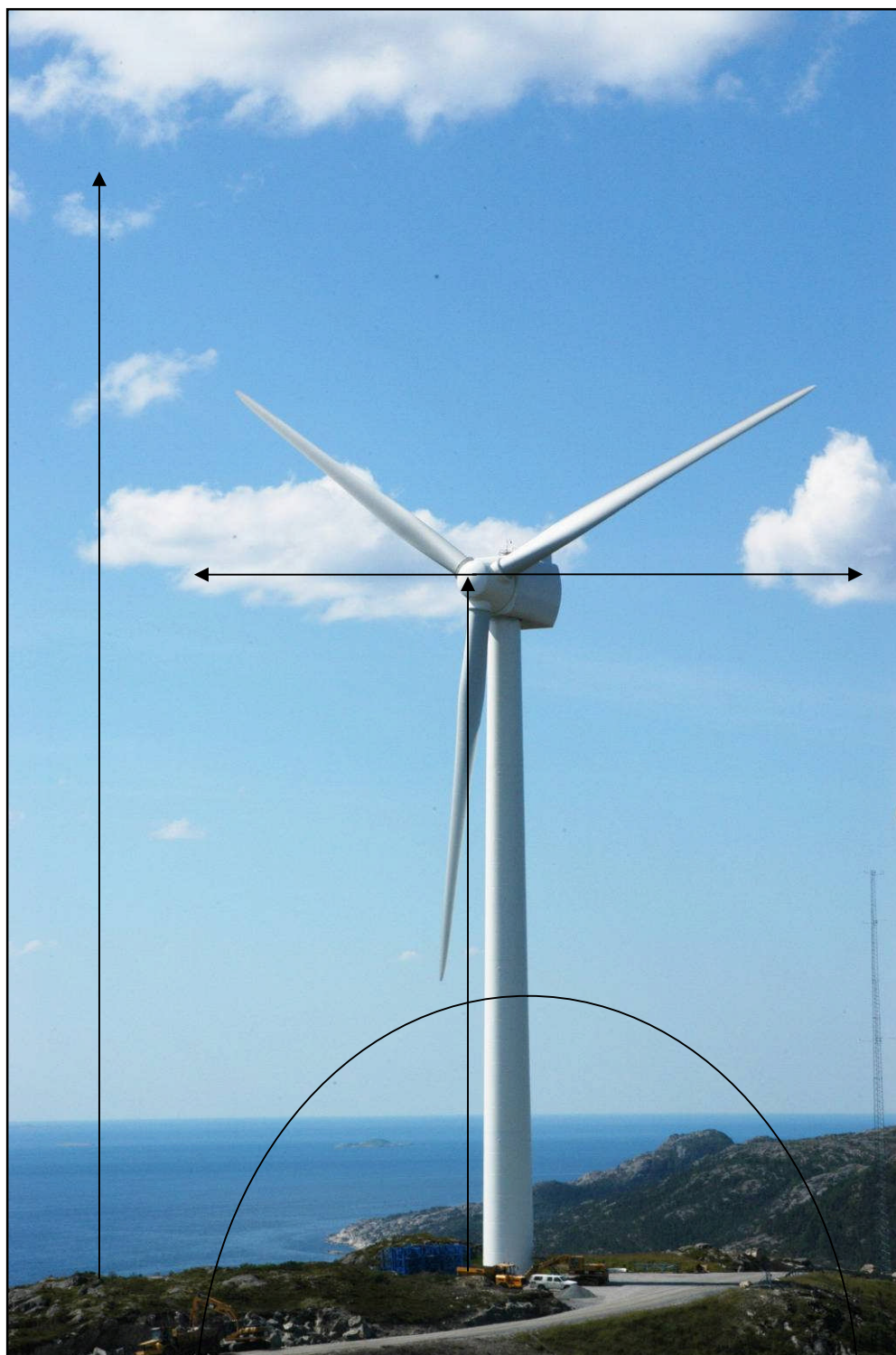
Figur 8 Målskisse for vindturbin på 3 MW
