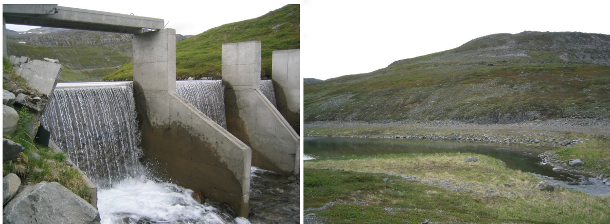
Bilde 3.7 Reguleringsanlegget i Lundstraumvatn m/overløp (t.v.) og reguleringssonen i Annasvatn (t.h.).
