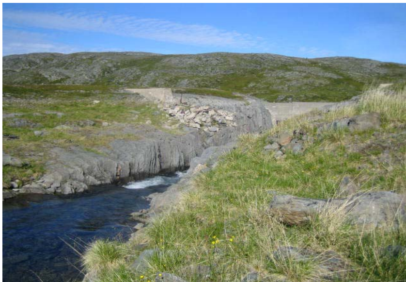
Bilde4 : Innløp mot dam i Annasvatn
