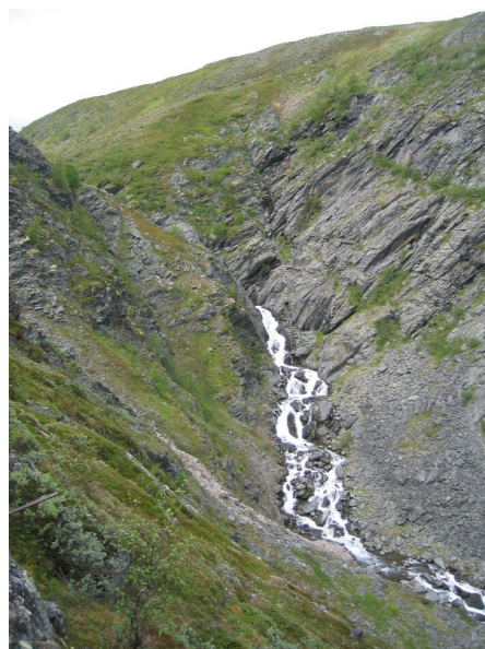
Bilde 3.3 Foss nedstrøms gammelt kraftverksinntak
