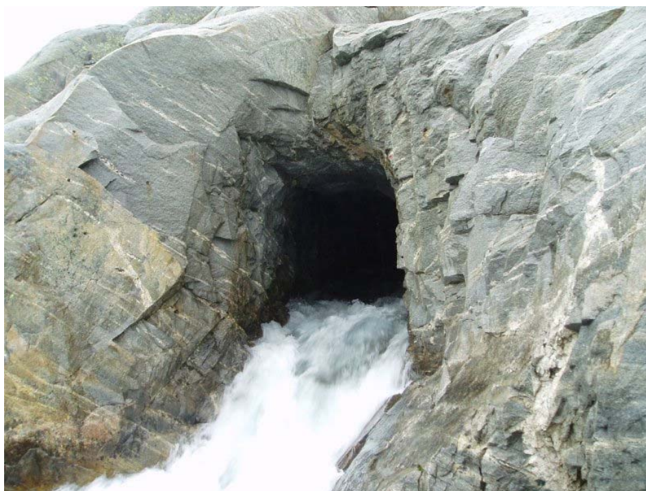
Bilde 4.4. Utløp av eksisterende overføringstunnel fra Sjuniofemtivatnet.
