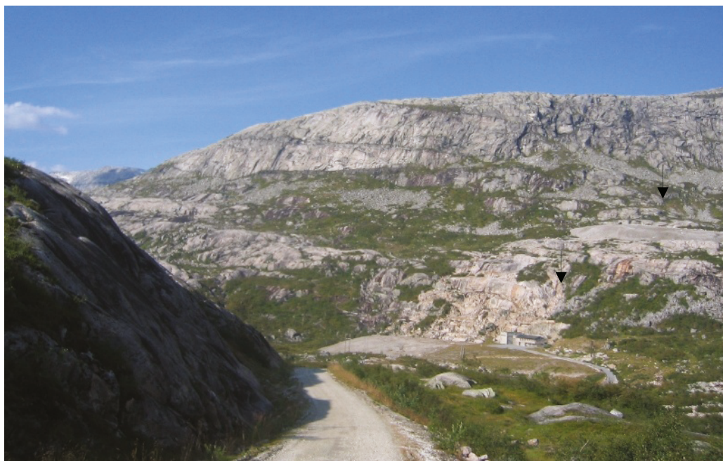
Bilde 3.2. I lia ovenfor eksisterende Fagervollan kraftstasjon ligger en av de frodigste lokalitetene i prosjektområdet. Fagervollan kraftstasjon og eksisterende massetipp ligger til høyre på bildet (markert med piler).
