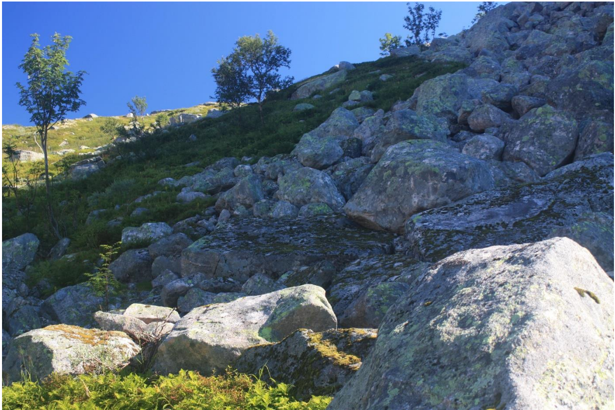
Bilde 5. Her blir rørgate dekket med torv eller på betongklosser.
