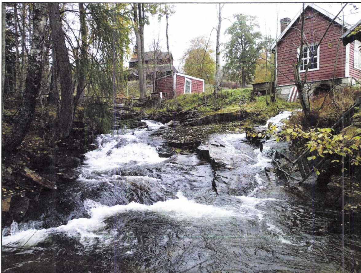
Figur 6. Avløpet fra kraftverket Kaupanger 1 (rød bygning til høyre i bildet). Elven er bratt i dette området, og fisk kan trolig kun vandre forbi stryket på bildet ved gunstige vannføringer.
