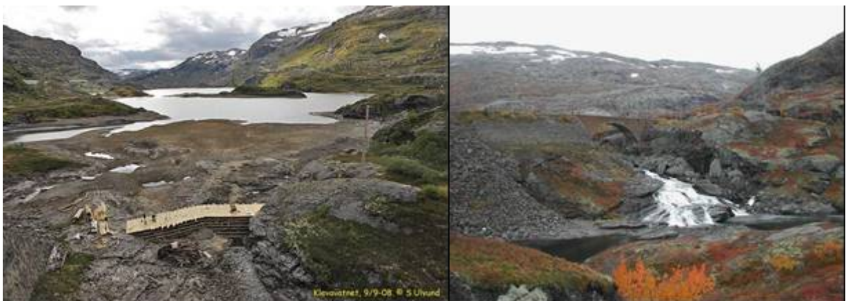
Rehabilitering av Klevadammen, nedtappet magasin. Flåmselvi like nedenfor Klevavatn og Bergensbanen.
